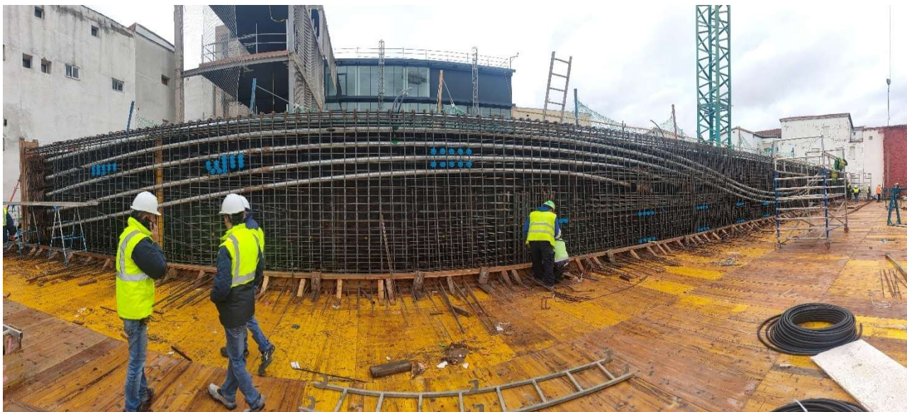
Figura 8. Viga durante el montaje del postesado
