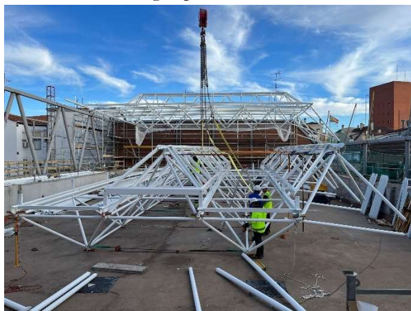
Figura 12. Cubierta espacial durante su montaje
