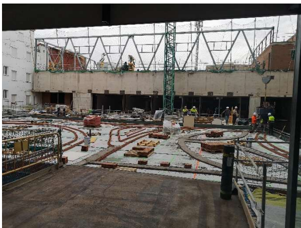
Figura 7. Modelo BIM del bloque piscina (superior) y bloque piscina en fase de construcción (inferior)
