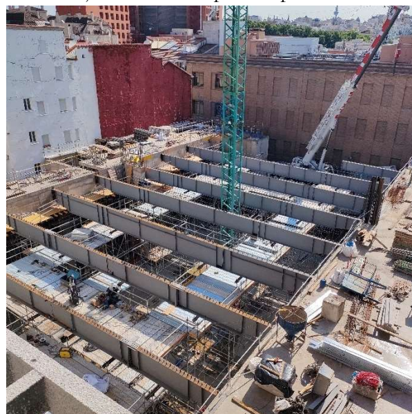
Figura 3. Vigas metálicas en fase de construcción
