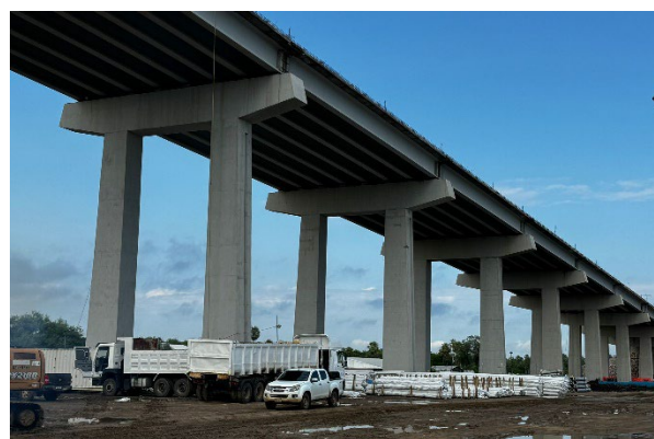
Figura 10. Viaducto de acceso
