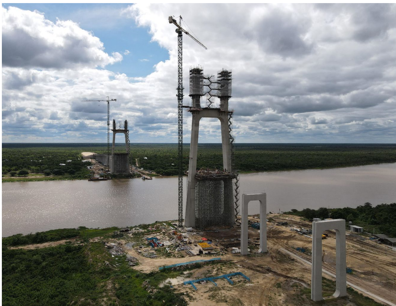
Figura 12. Vista aérea del avance de obra (diciembre de 2024)
