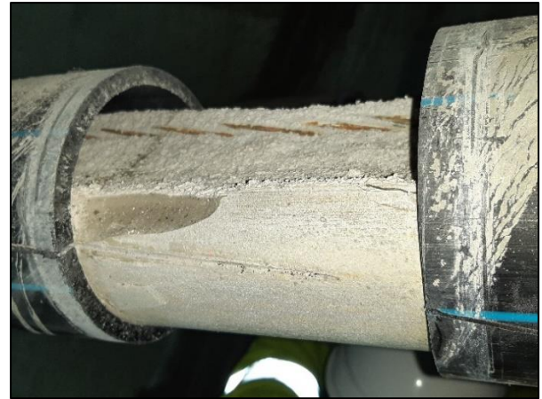
Figura 6. Apertura de ventanas.
