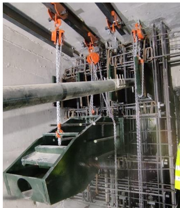
Figura 12. Sistema de izado de piezas.
