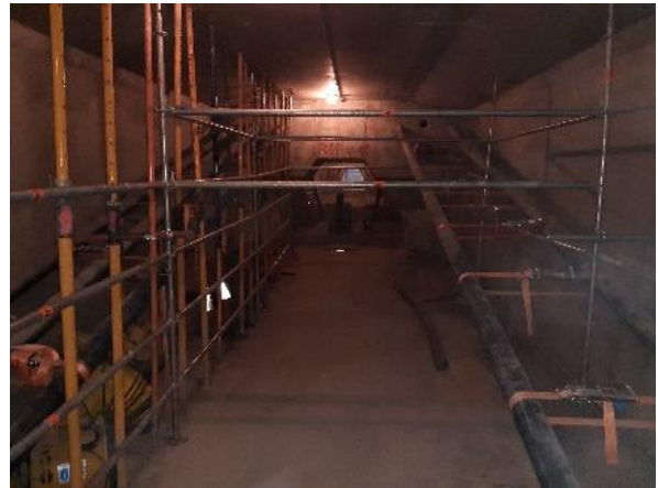
Figura 14. Apuntalamiento de seguridad.
