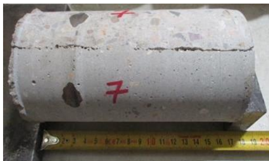
Figura 10. Obsérvese la existencia de varias juntas de hormigonada
