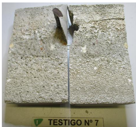
Figura 11. Obsérvese la porosidad del material de la junta
