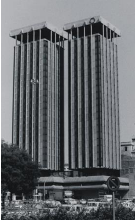
Figura 1. Edificios Torres Colón. Estructura suspendida colgada
