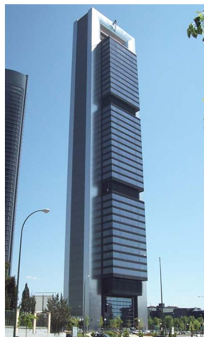
Figura 2. Torre CEPSA. Edificio suspendido apoyado
