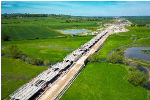
Figura 10. Avance de la construcción del viaducto (agosto 2024).
