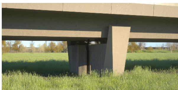
Figura 8. Detalle de las pilas que ocultan los aparatos de apoyo e integran visualmente tablero y subestructura.
