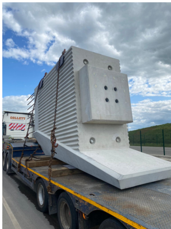
Figura 9. Transporte de pila totalmente prefabricada.
