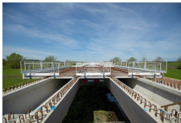
Figura 7. Construcción del tablero mediante el uso de prelosas prefabricadas.
