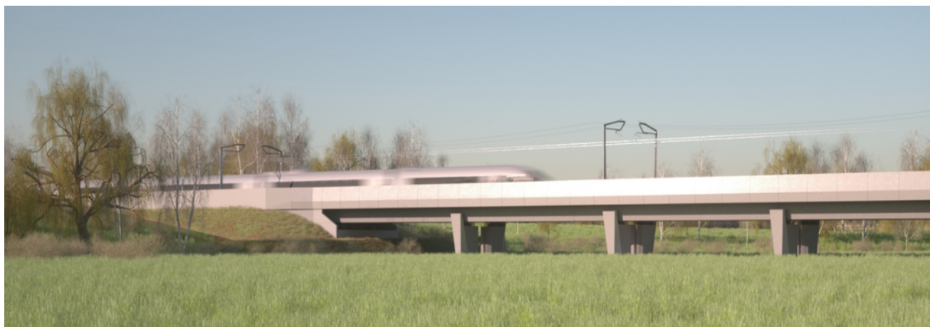
Figura 2. Extremo sur del Viaducto de Thame Valley y la transición con el terraplén.
