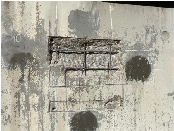
Figura 7. Se muestra una cala en al que se aprecia las diversas zonas en donde se situó la sonda de confinamiento ya que es necesario mojar la superficie
