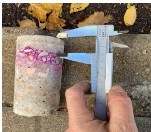
Figura 5. Aplicación de la fenolftaleína en los testigos para identificar la profundidad de carbonatación.
