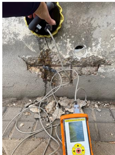
Figura 6. Medida de la velocidad de corrosión con el corrosímetro GECOR 10. En la parte superior se aprecia la sonda de medida circular que tiene un anillo de guarda para confinar al corriente.
