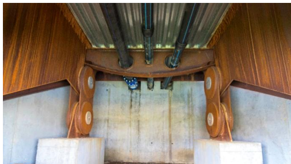
Figura 4. Articulación de doble bulón.
