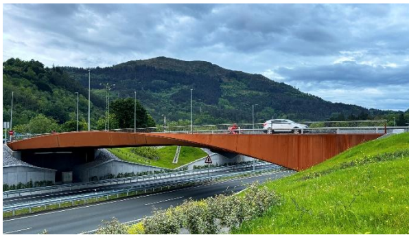
Figura 9. Puente Norte Rotonda Elevada Allerru sobre la N-I.
