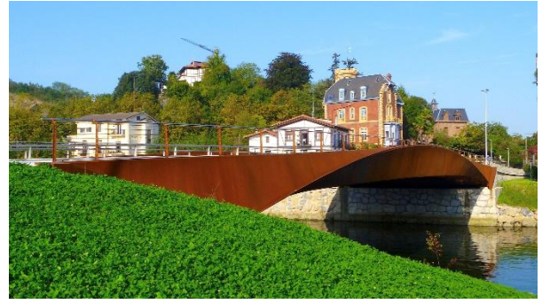
Figura 7. Puente bicontentio Martutene.
