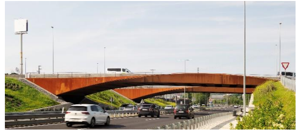
Figura 8. Rotonda Elevada Allerru sobre la N-I.
