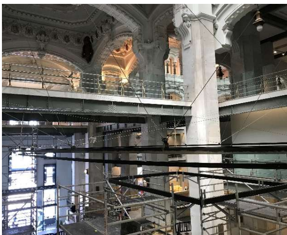
Figura 4. Montaje de la estructura de cuelgue.
