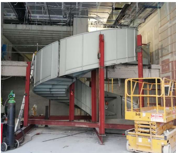
Figura 7. Montaje de la estructura de la escalera
