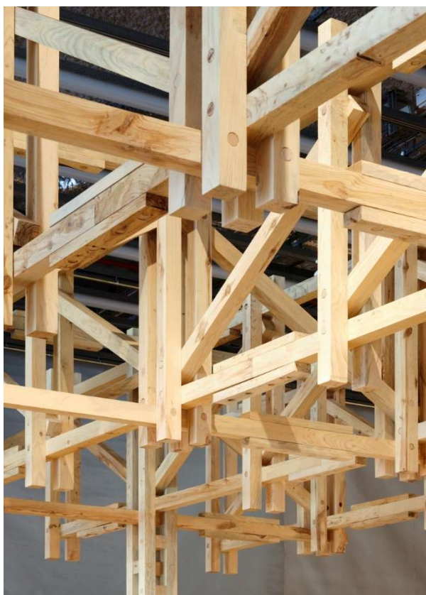
Figura 13. Detalle de los nudos de la celosía. (Foto: J. Hevia)
