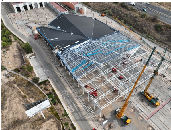
Figura 18. Fotografía de la estructura en construcción.
