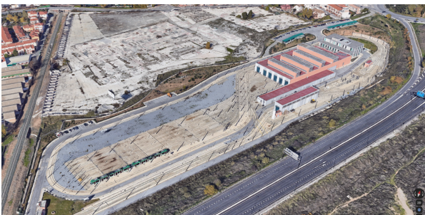
Figura 3. Vista aérea de los Talleres y Cocheras previamente a la actuación.
