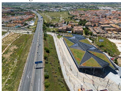
Figura 19. Fotografía de la estructura construida.
