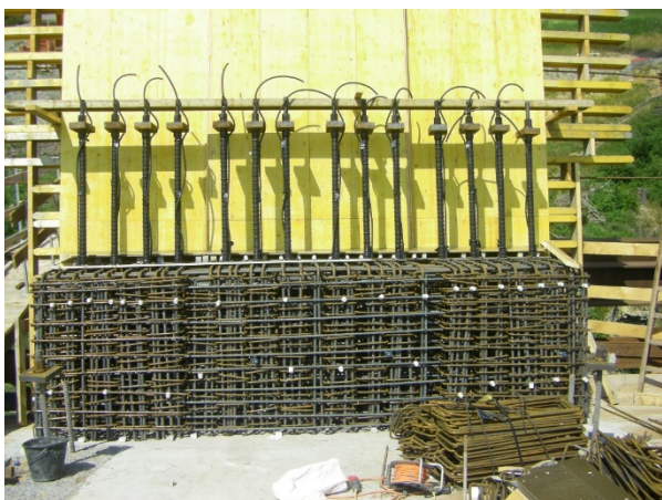
Figura 10. Armadura inferior de rótula
