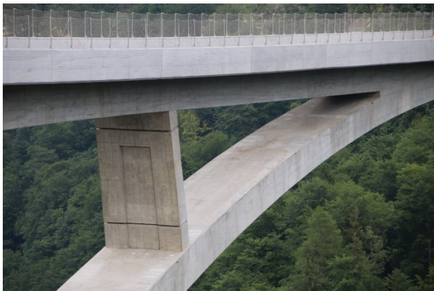
Figura 9. Detalle de unión de pilar con tablero.
