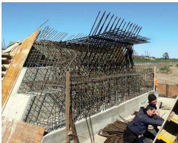
Figura 7. Armado de la rótula.
