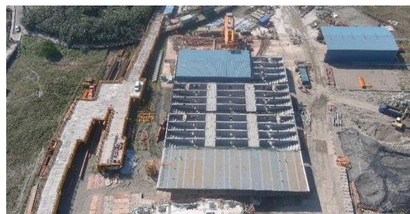
Figura 11. Montaje de segmentos de tablero en obra
