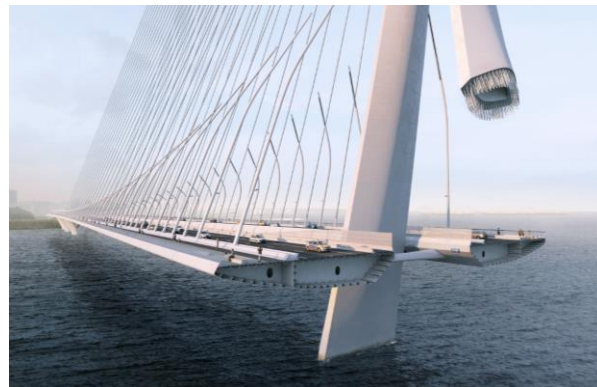
Figura 1 . Tablero ortótropo cajones gemelos , Fase 1
