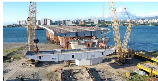
Figura 15 . Instalación del vano lateral Bali
