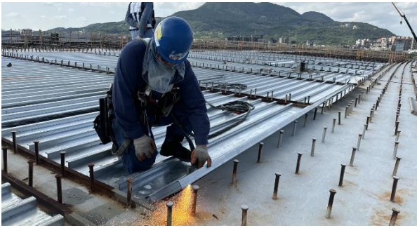
Figura 16 . Paneles de encofrado de losa mixta
