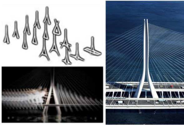
Figura 4 . Evolución de la forma del pilón en la competición
