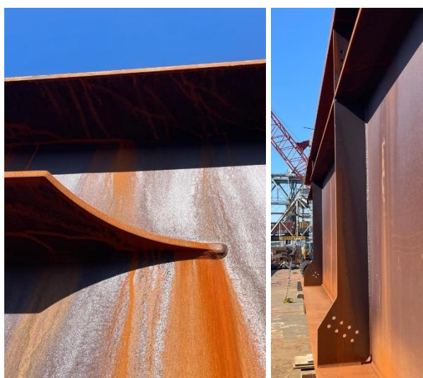
Figura 16. Detalles soldadura de Rigidizadores.
