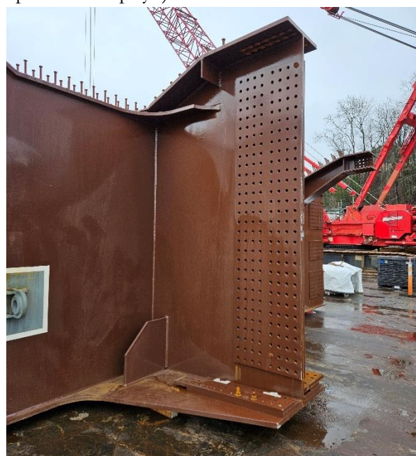
Figura 15. Conexión Atornillada Viga Longitudinal.
