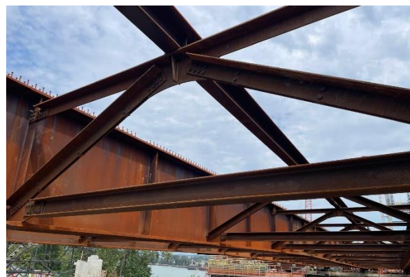
Figura 7. Diagonalización Transversal (Bracing).
