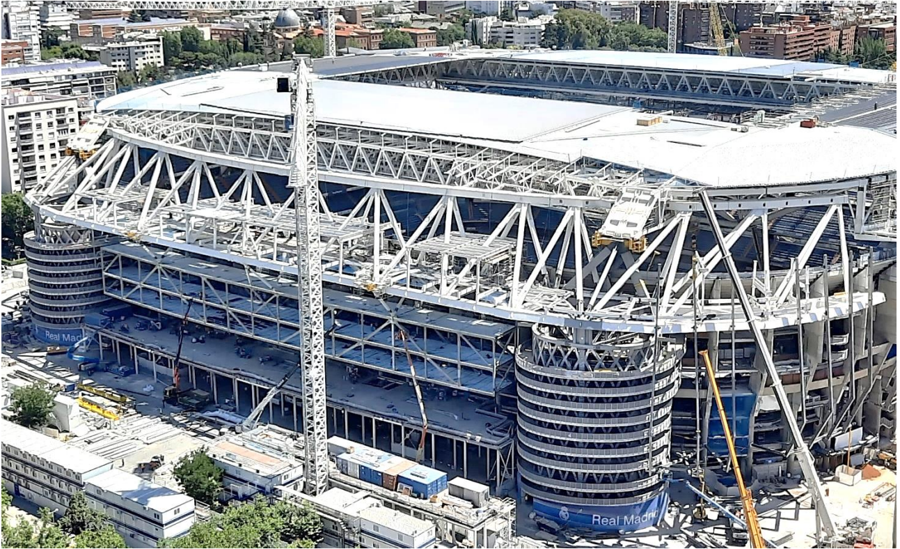
Figura 1. Vista general del Edificio Oeste [3]
