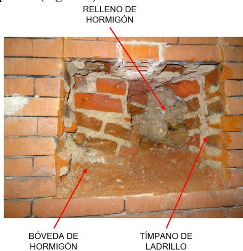
Figura 4. Cala en el tímpano este (proyecto de rehabilitación del puente de la CEA).
