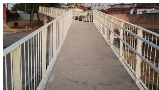
Figura 12. Nueva barandilla con doble pasamanos (rehabilitaci3n de la pasarela Dr. Carmena-Ruiz).
