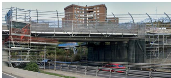
Figura 7. Andamio instalado en las márgenes (rehabilitación del puente de la Lira sobre la M-30).
