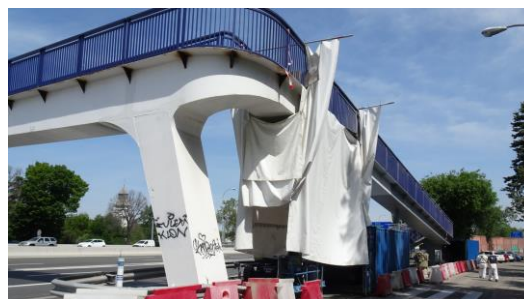
Figura 15. Encapsulamiento para la reparación de la estructura metálica durante el día (rehabilitación de la pasarela de Fuentelarreina).
