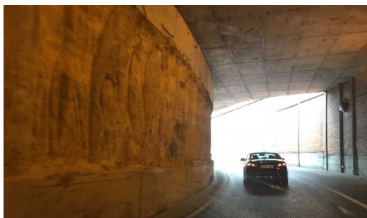
Figura 6. Revestimiento demolido (paso inferior del ramal que conecta la calzada izquierda de la M-30 con la avenida de América).
