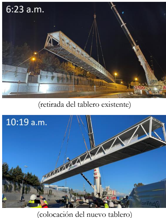
Figura 11. Sustituci3n del vano V-2 de la pasarela de Ram3n y Cajal.
