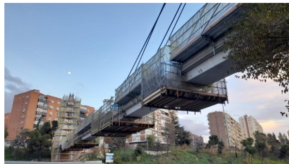
Figura 8. Andamio instalado en el tablero (obra de sustitución de tirantes de la pasarela de Marqués de Zafra).
