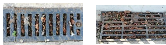
Figura 18. Canaleta (izquierda) y sumidero (derecha) obturados en la pasarela de la CEA.
