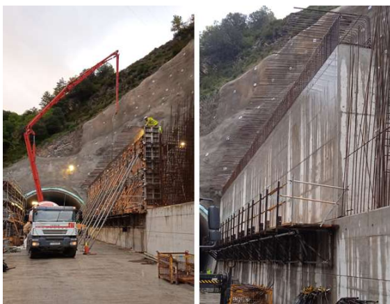
Figura 13. Encofrado y hormigonado de zona 1 fase 2 de hastial izquierdo.
