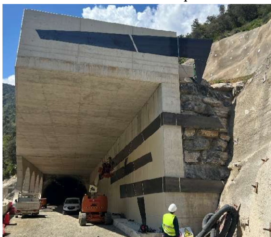
Figura 32. Instalación de paneles de acero corten en hastial izquierdo, peto y cierre con la ladera.
