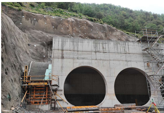
Figura 30. Ejecución de transición con emboquille del túnel.
