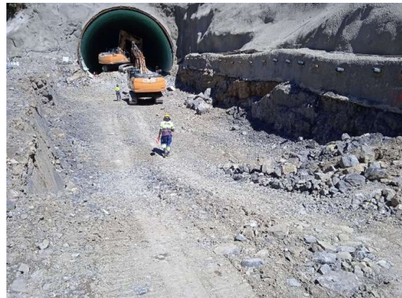
Figura 7. Trabajos de preparación del terreno para apoyo de losa inferior.
