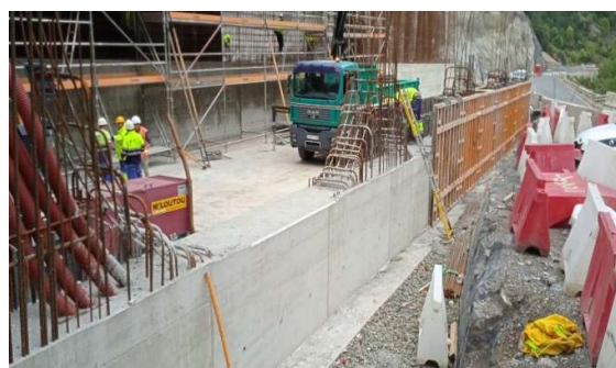
Figura 15. Hormigonado de fase 1 de hastial derecho.
