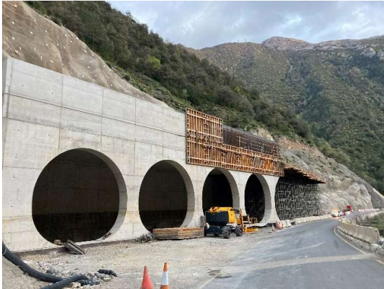
Figura 25. Ferrallado y encofrado de peto lateral.
