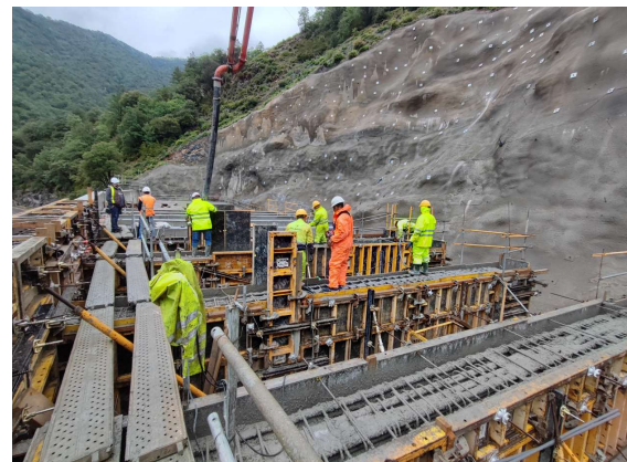
Figura 23. Encofrado y hormigonado de contrafuertes en dintel.
