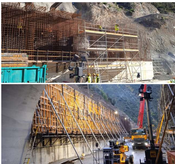
Figura 12. Ferrallado y encofrado de zona 1 fase 2 de hastial izquierdo.
