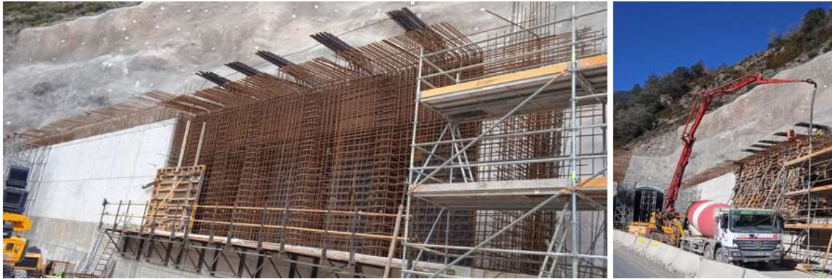
Figura 21. Ferrallado, encofrado y hormigonado de zona 2 del hastial izquierdo. Contrafuertes.
