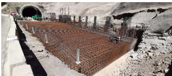
Figura 8. Ferrallado de losa inferior y esperas para arranques de muros y contrafuertes.
