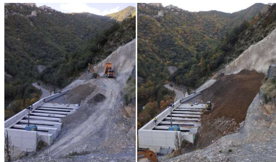
Figura 29. Ejecución de relleno sobre dintel.
