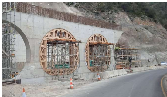
Figura 18. Hastial derecho ya hormigonado, con los encofrados ovalados para las ventanas sin retirar.
