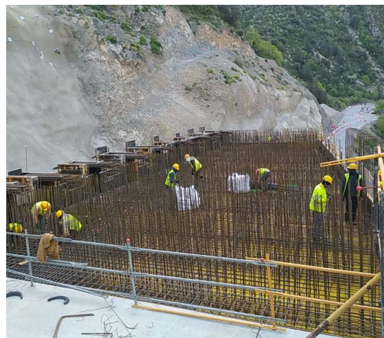
Figura 20. Ferrallado del dintel en zona cerrada.
