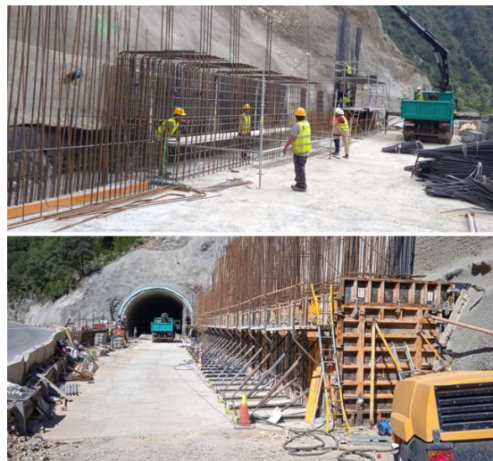
Figura 10. Ferrallado y encofrado de zona 1 fase 1 de hastial izquierdo.
