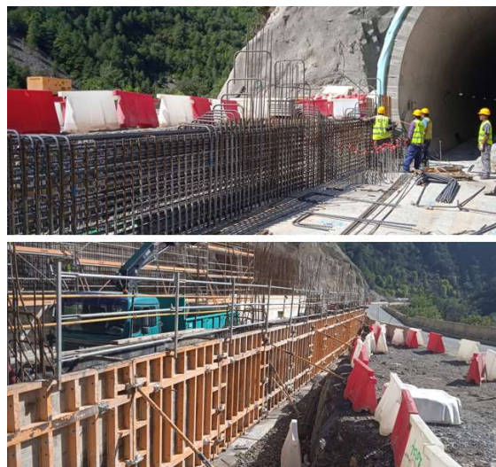
Figura 14. Ferrallado y encofrado de fase 1 de hastial derecho.
