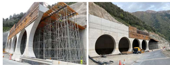
Figura 19. Cimbra y encofrado para ejecución de dintel, zona cerrada.
