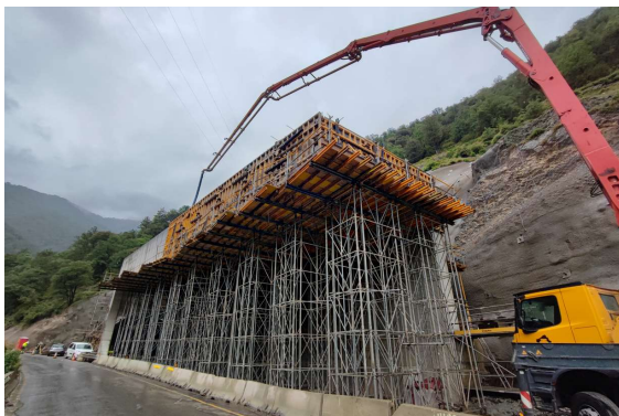
Figura 22. Cimbra y encofrado para ejecución de dintel, zona abierta (visera).
