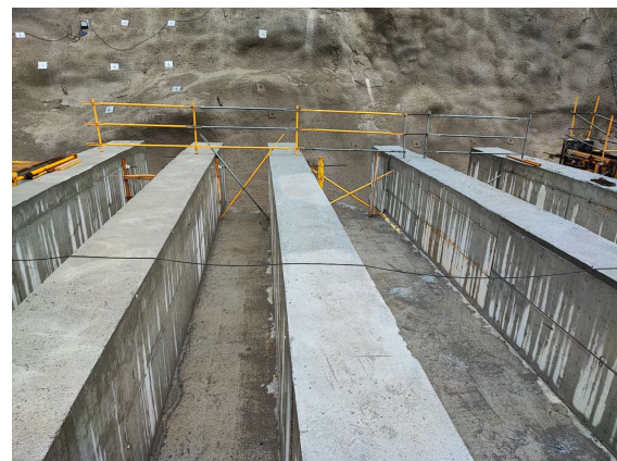
Figura 24. Vista de nervios en dintel zona visera, ya hormigonados.
