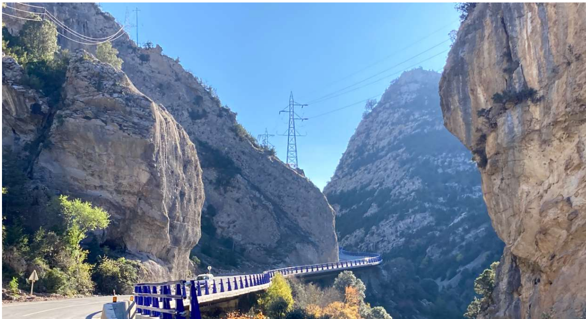
Figura 23. Vista aérea de tramo de voladizos terminados.
