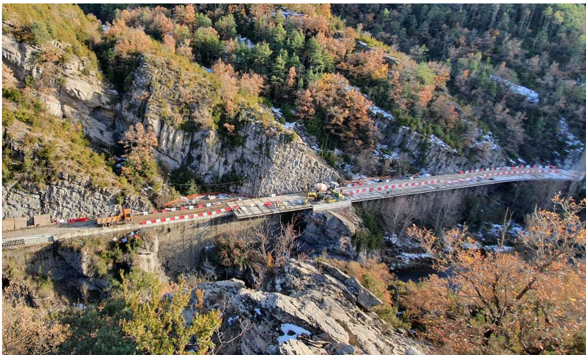
Figura 20. Vista aérea de tramo de voladizos en ejecución.
