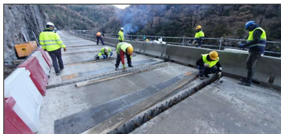
Figura 21. Ferrallado de juntas transversales entre placas.
