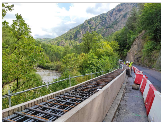
Figura 16. Vigas riostras premontadas colocadas en posición.
