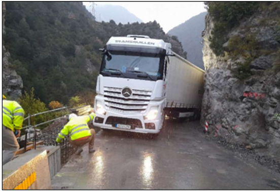
Figura 11. Camión circulando por la calzada durante las obras.
