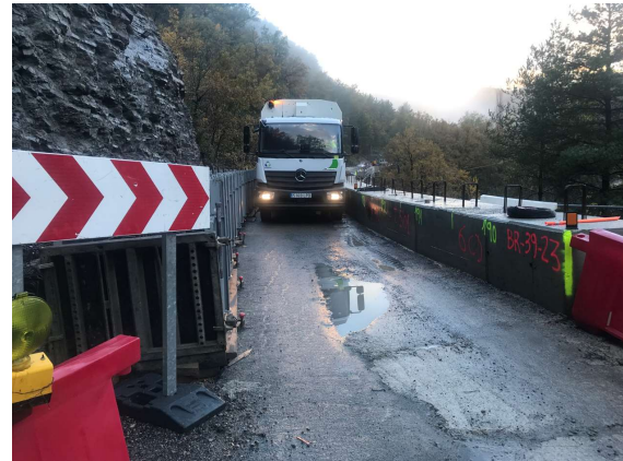
Figura 14. Viga riostra premontada en proceso de colocación.
