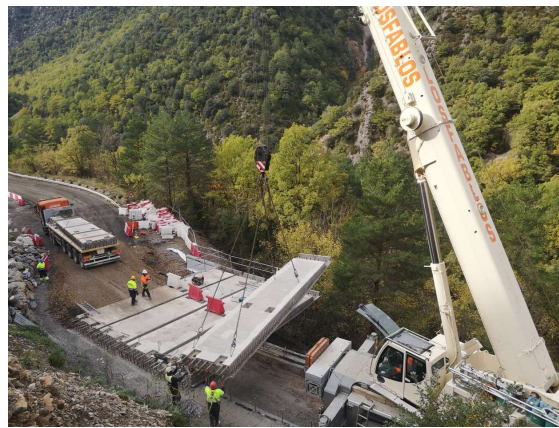
Figura 18. Colocación de prelosa en corte diurno de tráfico.
