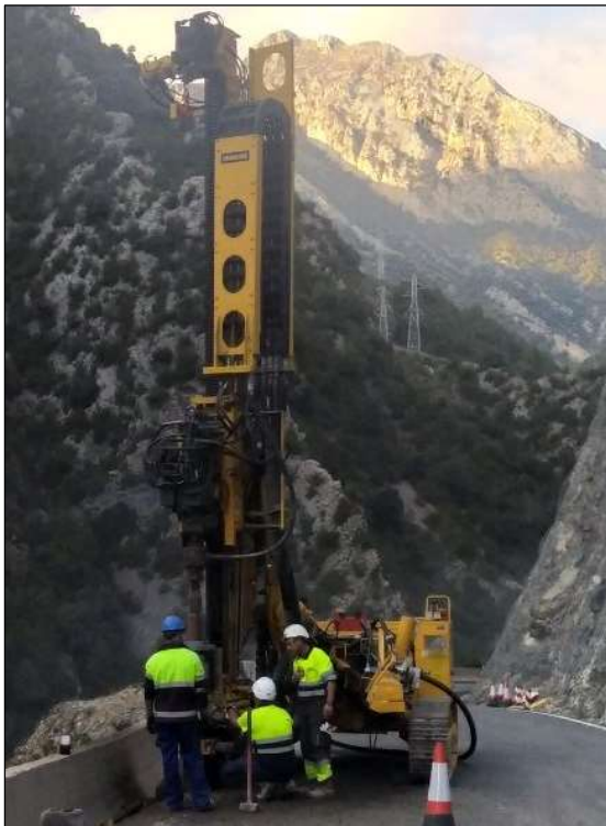
Figura 7. Máquina de micropilotes trabajando.
