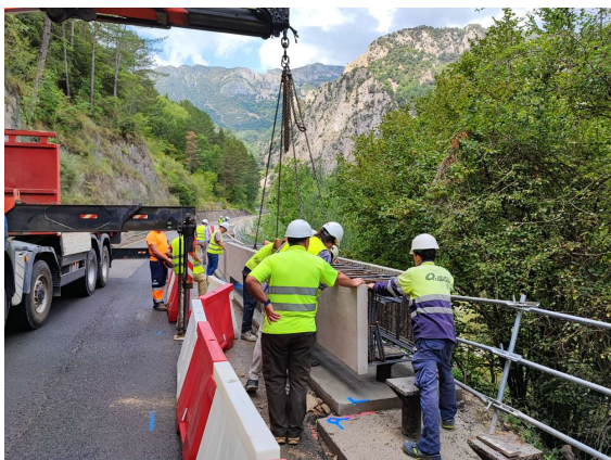
Figura 15. Viga riostra premontada en proceso de colocación.
