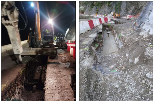
Figura 12. Imágenes de ejecución de viga riostra trasera.
