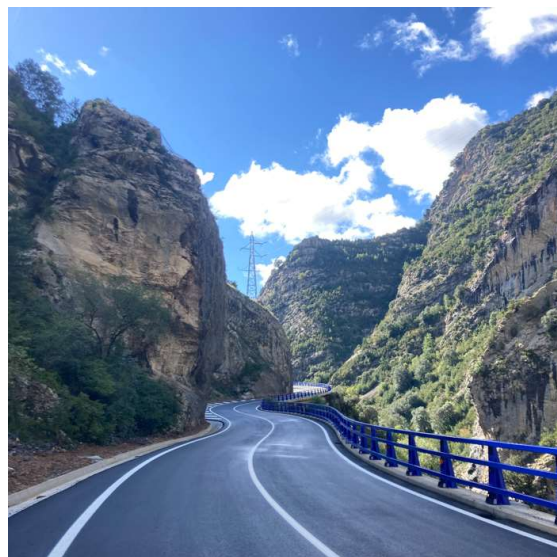
Figura 22. Vista de tramo ampliado terminado.
