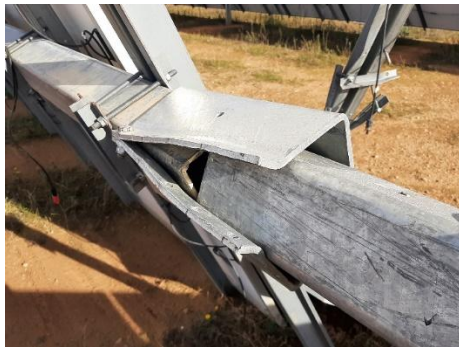
Figura 4. Forma de fallo por torsión en un empalme del tubo principal. La inestabilidad permite absorber suficiente energía del viento para provocar la rotura de tornillos estructurales y piezas metálicas de espesor considerable.
