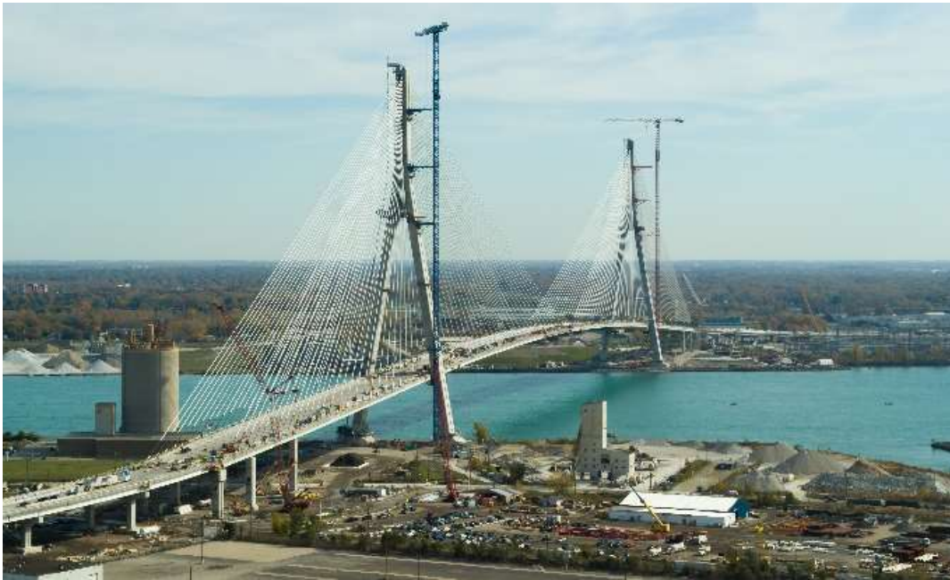
Figura 1. Vista general del puente
