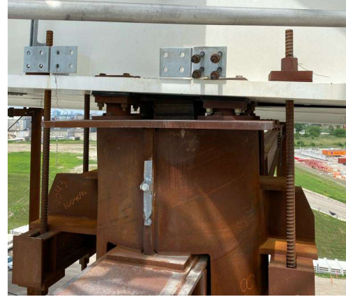
Figura 3. Apoyo del tablero sobre la pila provisional.
