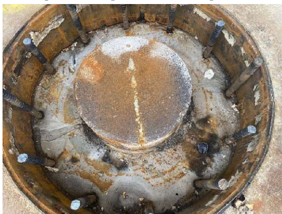
Figura 9. Interior de un gato de arena, una vez retirada la pila.
