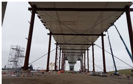
Figura 8. Vista inferior del vano de retenida sobre las pilas provisionales de apeo.
