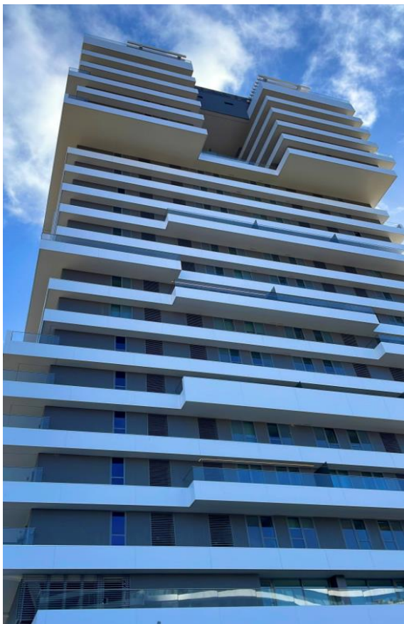
Figura 13. Vista de los voladizos durante la construcción.
