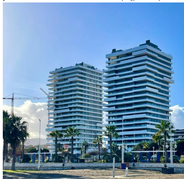
Figura 18. Vista general de la construcción de las torres del río
