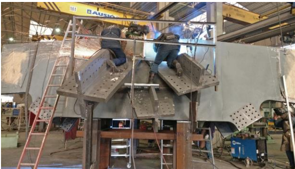
Figura 4. Ejecución del nudo de la Corona en el taller
