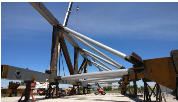
Figura 14. Premontaje en blanco de módulo de corona en taller.
