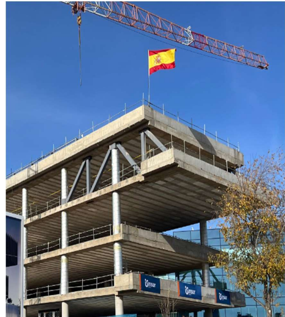
Figura 9. Celosía metálica y voladizo.
