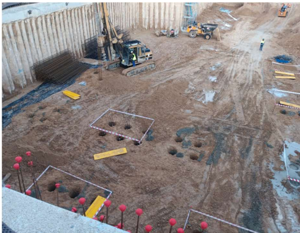
Figura 2. Muro perimetral y cimentaciones.
