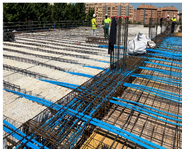
Figura. 6: Continuación del pretensado de los nervios en zona de losa maciza
