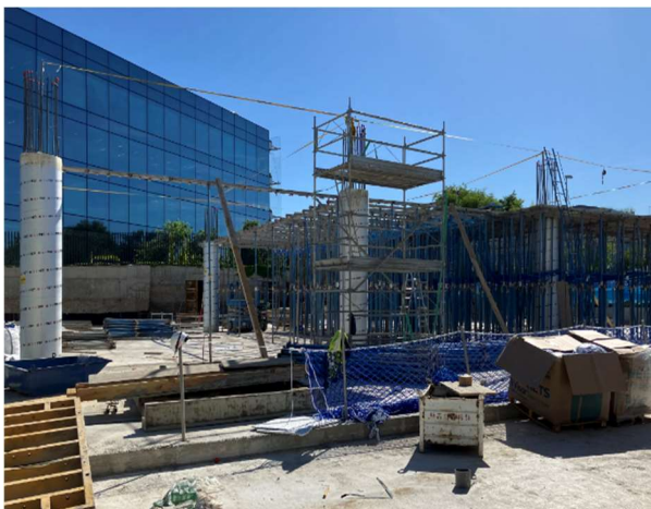
Figura 3. Pilares sobre rasante.
