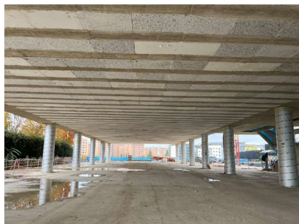
Figura 4. Forjado luz 15.4m.
