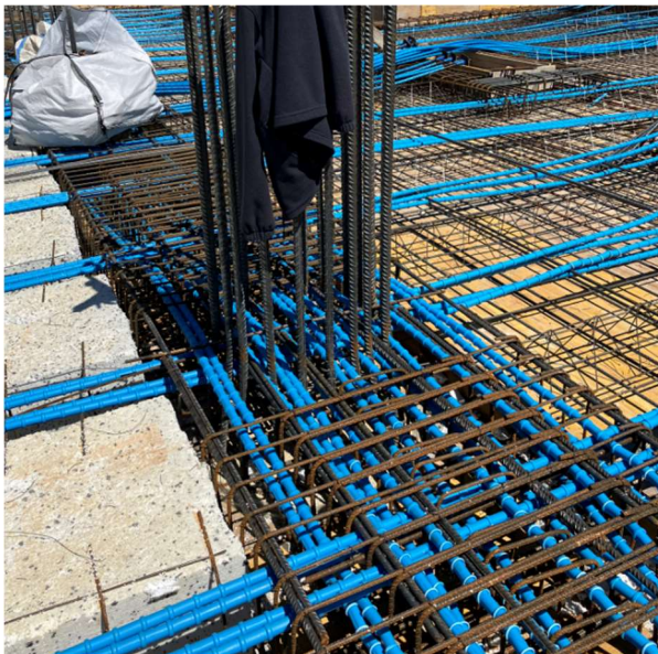
Figura 8. Cruce de armaduras activas y pasivas.
