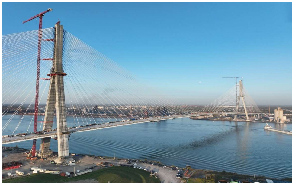
Figura 1. Vista general del puente
