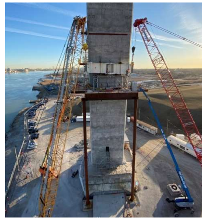
Figura 4. Montaje de la viga de arranque del tablero sobre las ménsulas de apoyo en la torre.
