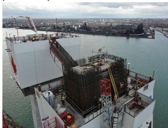
Figura 7. Vista superior del encofrado trepante – plataforma superior con pasarela (torre Canadá).
