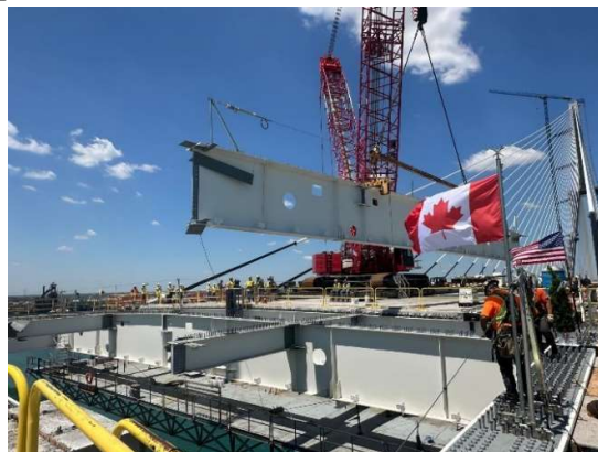
Figura 9. Montaje de una viga transversal. Se ven las vigas longitudinales secundarias en espera.
