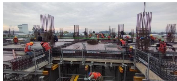
Figura 1. Ejecución de marcos rígidos de hormigón armado del Hospital de Parral.
