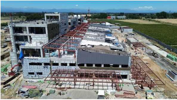
Figura 3. Estructura sobre aislamiento del Hospital de Parral.
