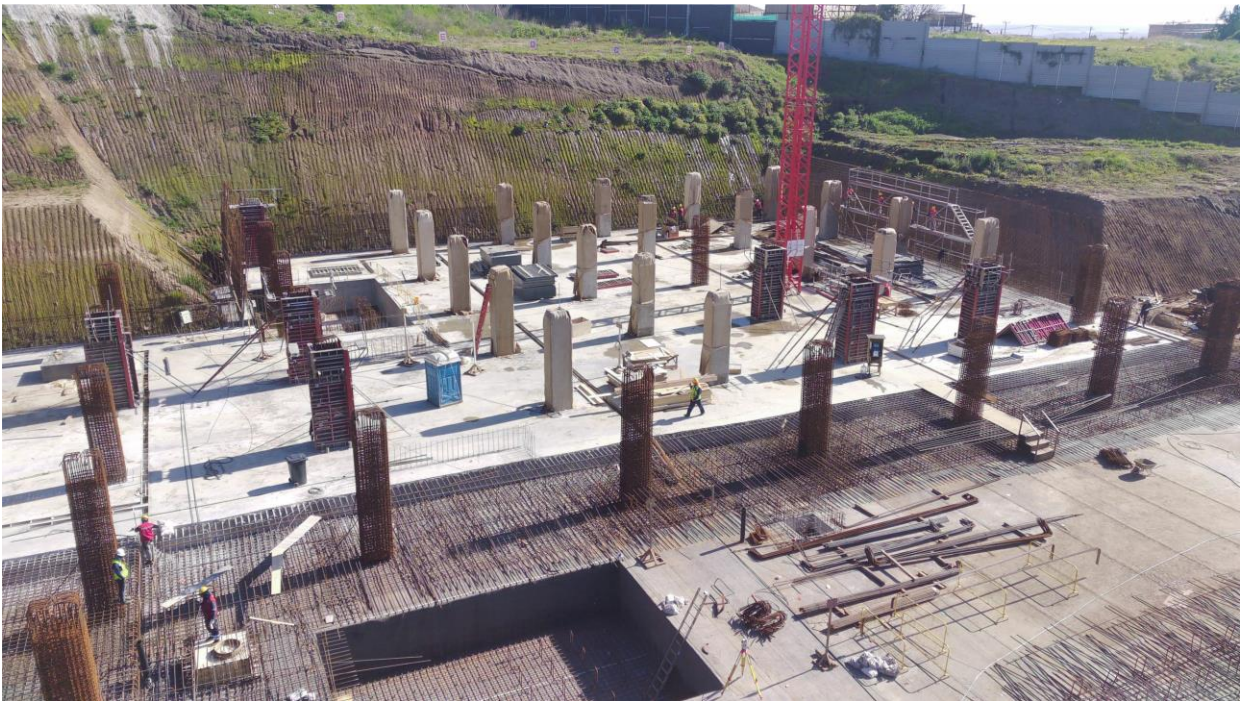
Figura 9. Cimentación del Hospital de Parral
