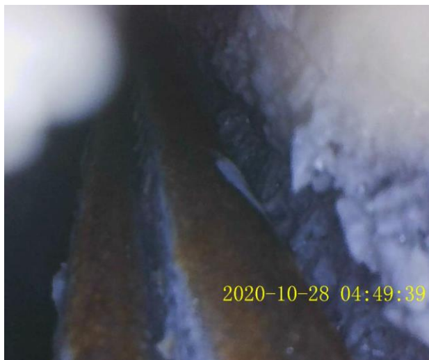
Figura 11. Inspección con boroscopio del interior de la vaina.
