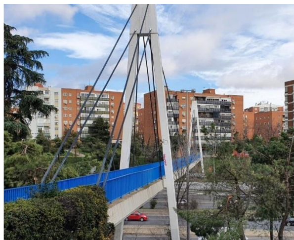
Figura 1. Vista general de la pasarela.
