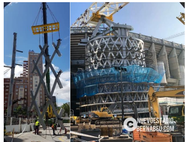
Figura 6. Montaje de los sectores cilíndricos de la cesta (izquierda) y torre durante la construcción (derecha)
