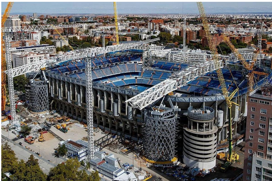
Figura 7. Estructura metálica de las torres completada
