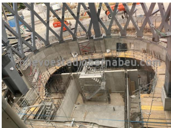
Figura 13. Vista de la nueva cesta metálica de la torre y del arranque de los elementos de hormigón en el sótano [3]
