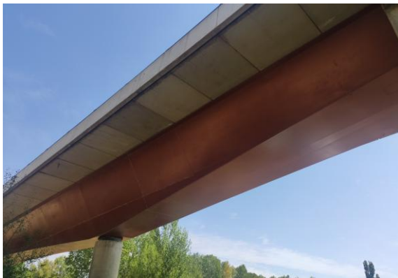
Figura 1. Vista inferior del tablero.
