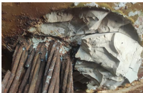
Figura 6. Parte inferior de la riostra donde se observa la doble inyección existente: en el interior de la vaina y rellenando el hueco exterior.
