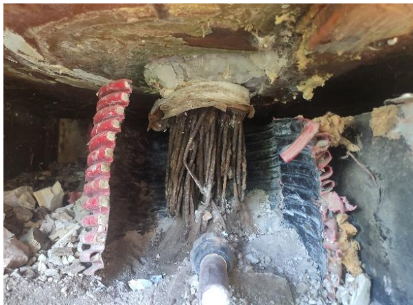
Figura 4. Estado de los cables de pretensado del apoyo situado en la zona del levantamiento.
