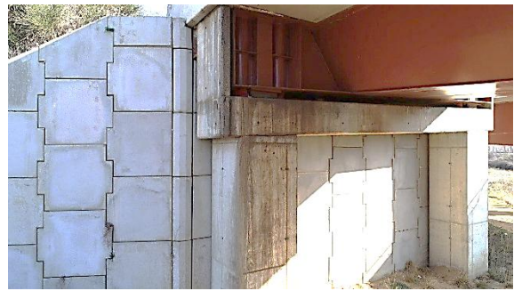
Figura 2. Estríbo E-2 de la calzada izquierda.
