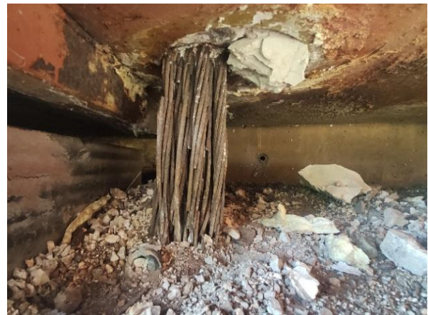
Figura 4. Estado de los cables de pretensado del apoyo situado en la zona del levantamiento.
