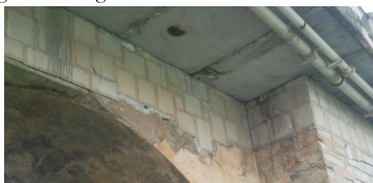
Figura 1. Zuncho longitudinal revestido (a la vista en Vano 10)
