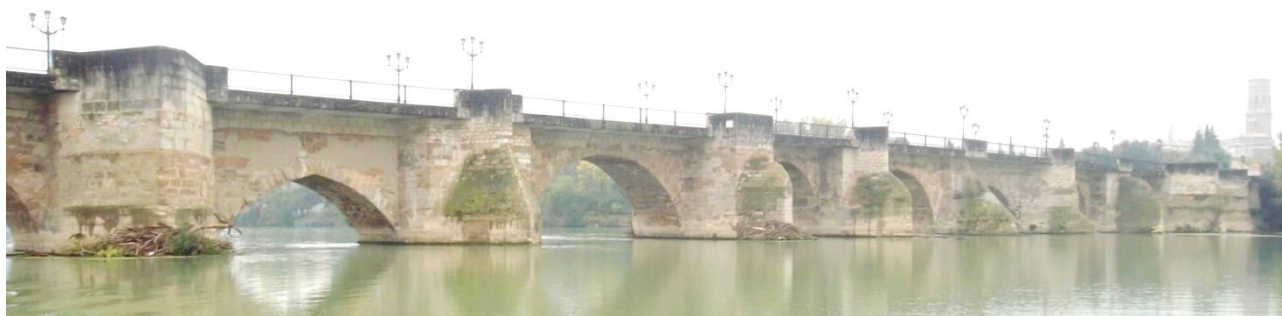
Figura 2. Vista del puente de fábrica situado en el municipio de Tudela
