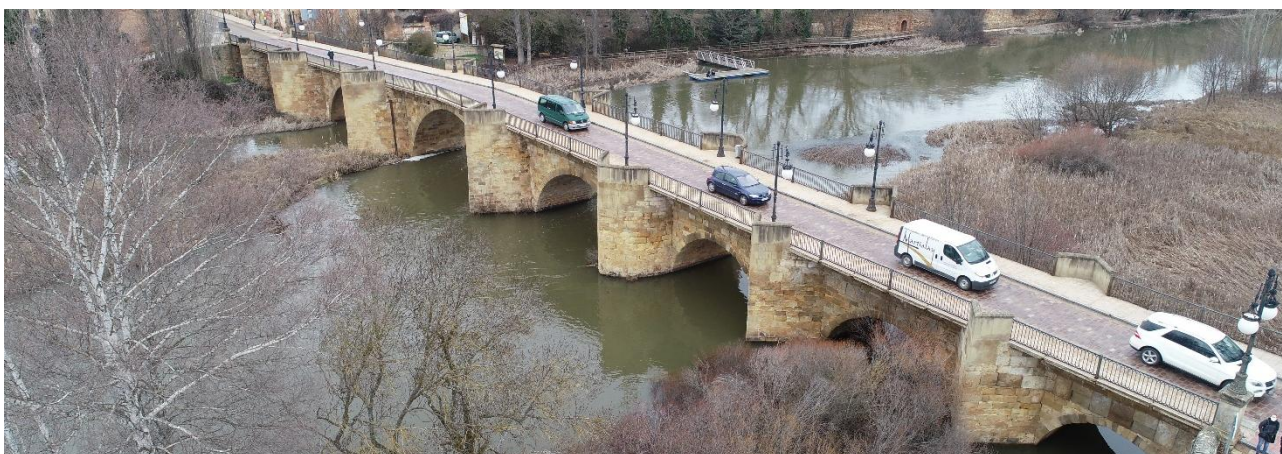
Figura 3. Vista del puente de fábrica situado en el municipio de Soria
