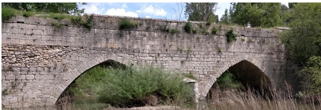
Figura 4. Vista del puente de fábrica situado en las proximidades del municipio de Alcazárén
