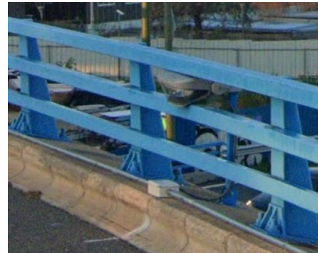
Figura 12. Colocación de elementos de iluminación en el pretil.
