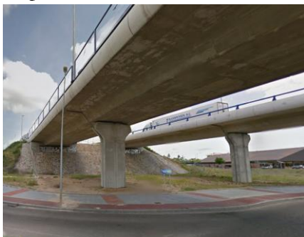
Figura 11. Báculo existente en la calzada inferior que impide la ejecución de recrecidos o ménsulas.
