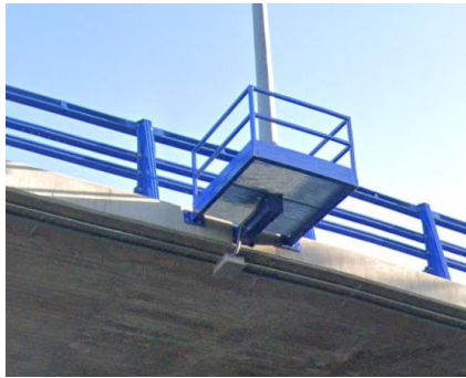
Figura 9. Ejemplo de ejecución de ménsula metálica para colocación de báculo.
