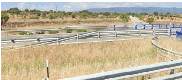
Figura 3. Ejemplo de transición entre pretil metálico y barrera metálica.
