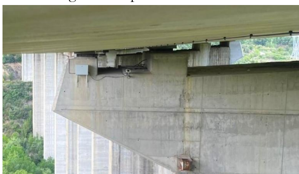
Figura 4. Dispositivo medidor de la flecha.
