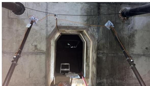
Figura 11. Foto detalle de los puntales instalados.
