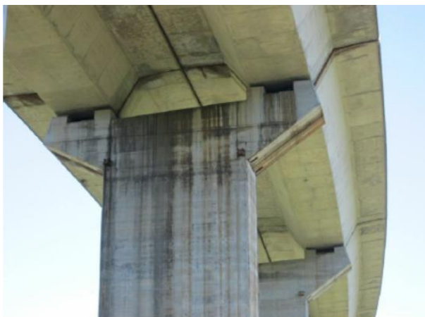
Figura 2. Vista inferior del tablero.
