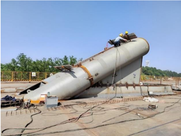
Figura 8. Ejecución del arranque del arco
