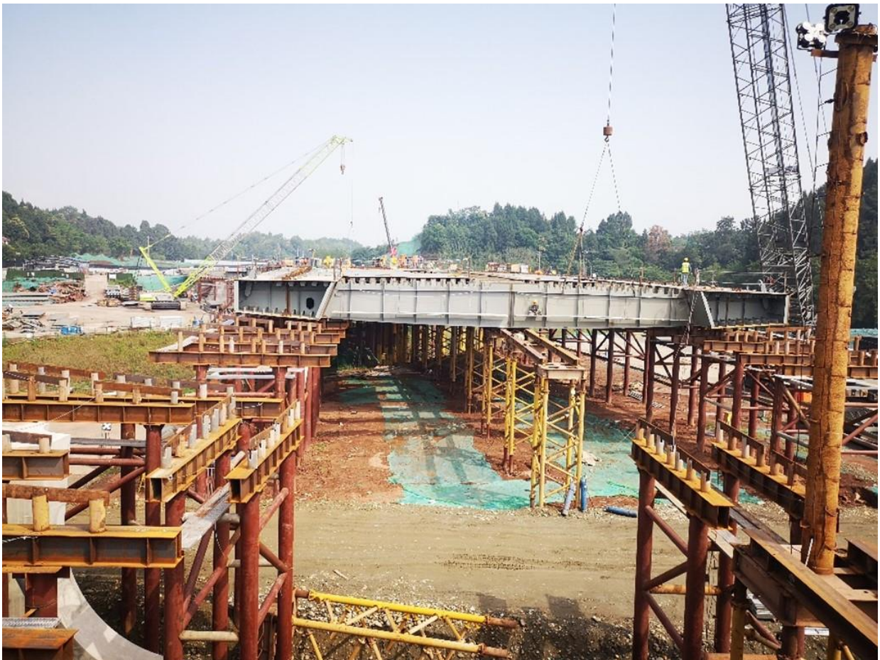
Figura 9. Montaje del tablero sobre apeos
