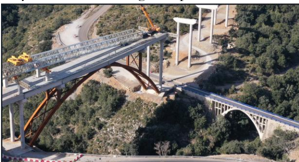
Figura 4. Vista general arcos nuevos y existentes (Fuente: UTE Puerto Querol).
