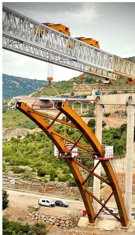
Figura 19. Montaje arcos.
