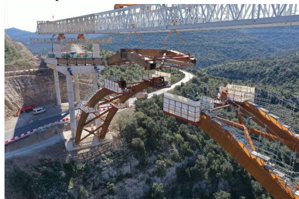
Figura 20. Montaje de clave de arcos.
