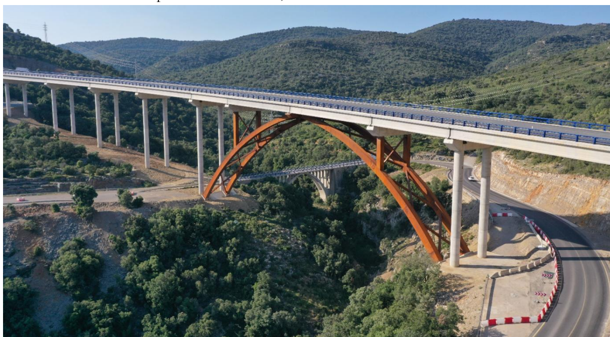
Figura 21. Vista General Viaducto de La Bota.
