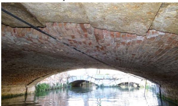
Figura 5. Vista inferior de la bóveda original.
