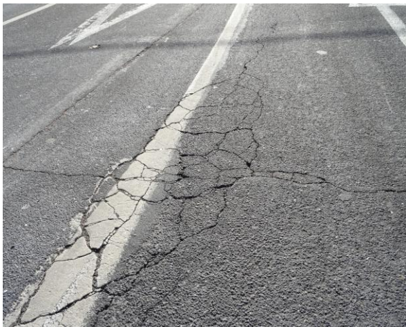
Figura 8. Blandón existente en la plataforma.
