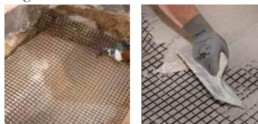
Figura 12. Colocación de la malla de fibra y extensión de la segunda capa de mortero
