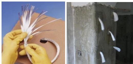
Figura 13. Sistema de anclaje de cuerdas de fibra de vidrio
