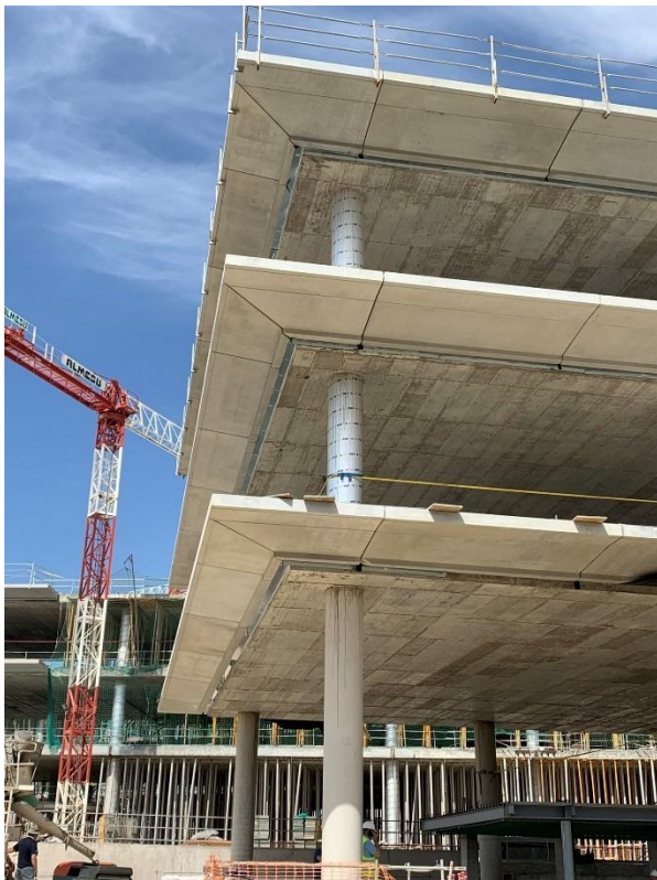
Figura 13. Voladizos prefabricados montados. Los frontales del edificio son el tipo 2 y los laterales el tipo 1
