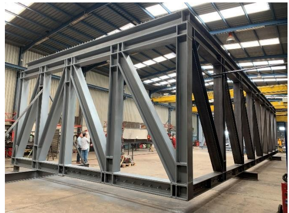
Figura 15. Montaje en blanco de celosía “balcón” de 4 m de altura
