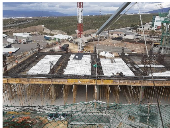
Figura 8. Montaje de forjado aligerado. Vista general
