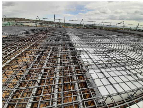
Figura 9. Montaje de forjado aligerado. En la parte izquierda de la fotografía se encuentra la viga transversal pretensada con ocho cordones
