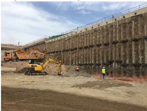
Figura 5. Contención perimetral en zona norte de la parcela
