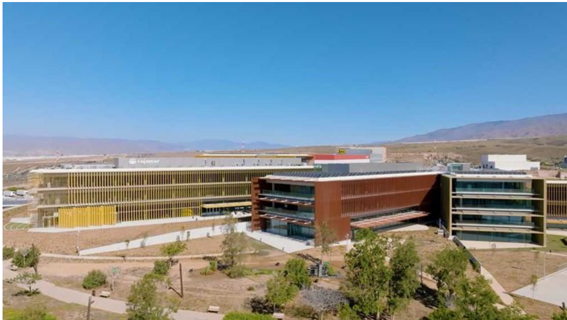
Figura 20. Vista de la obra terminada
