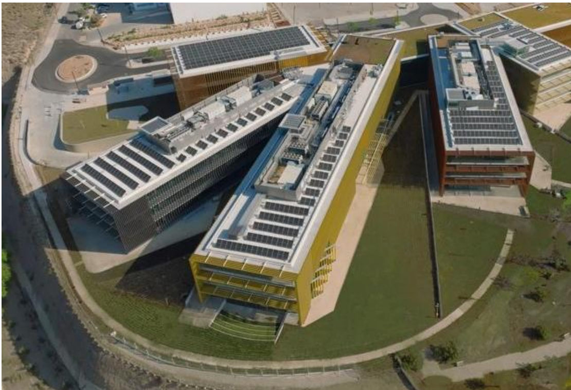
Figura 21. Vista de la obra terminada
