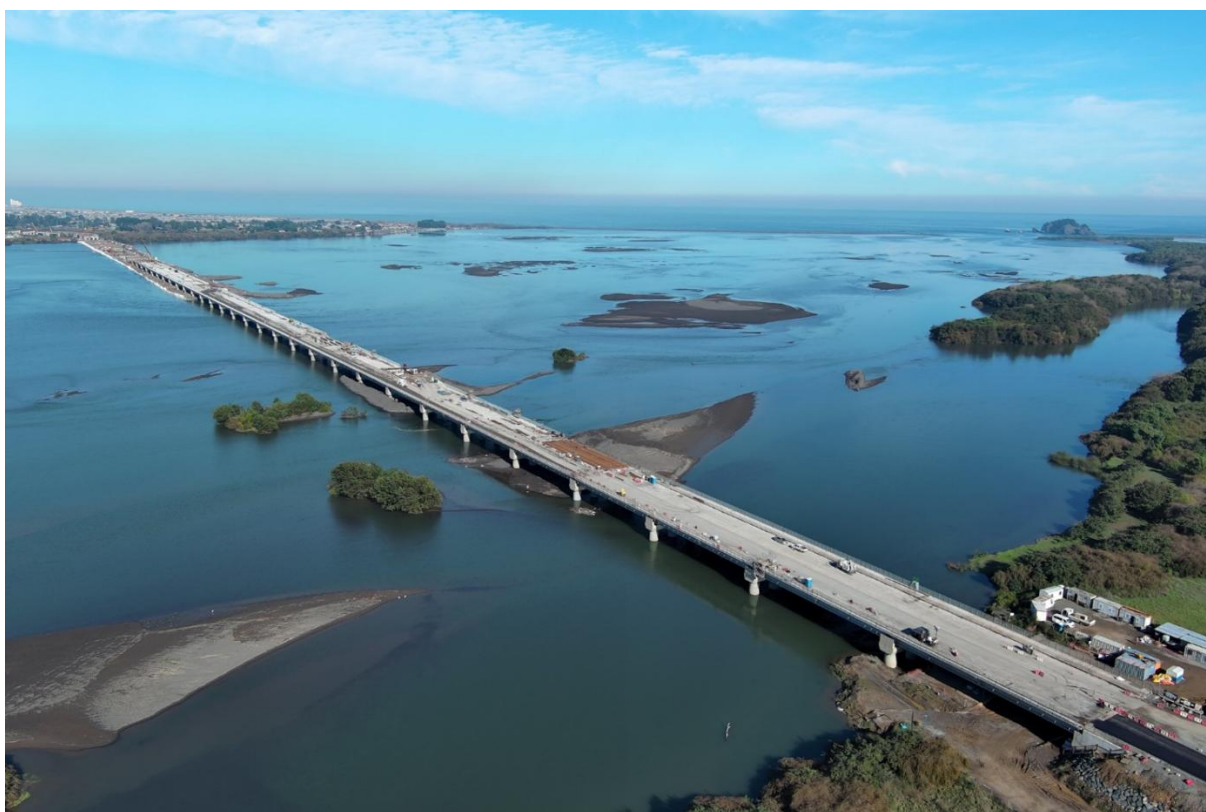
Figura 22. Vista general nuevo puente ferroviario sobre el río Biobío
