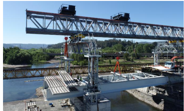
Figura 14. Colocación de prelosas
