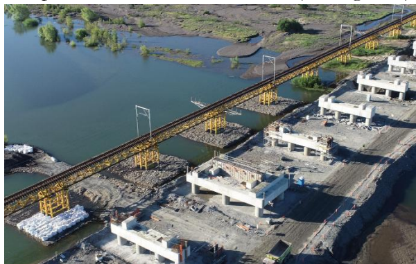
Figura 8. Vista general encepados tramo 3
