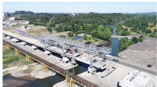
Figura 21. Montaje de vano con lanzavigas
