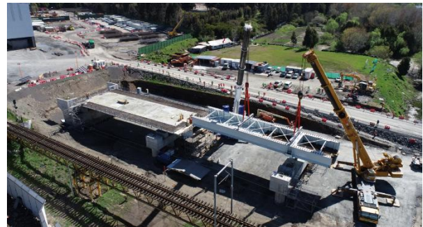
Figura 20. Montaje con grúas autopropulsadas
