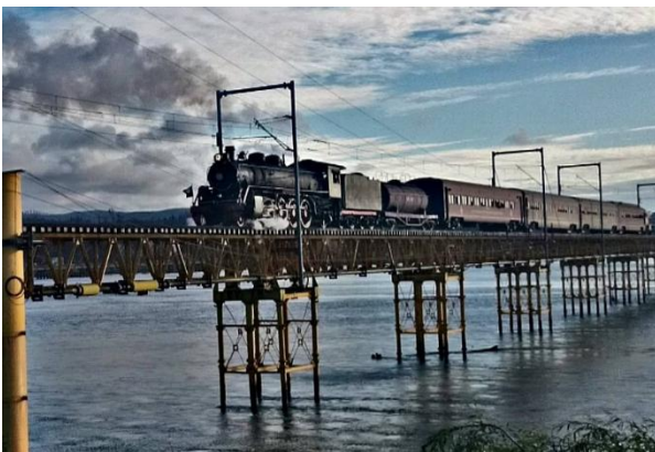
Figura 2. Vista general puente existente (Fuente: Google Maps)
