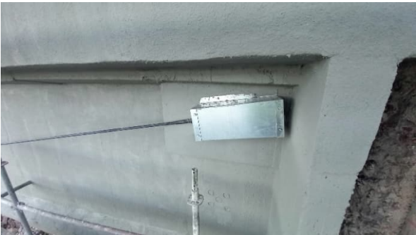
Figura 22. Refuerzo mediante anclaje 1R15.
