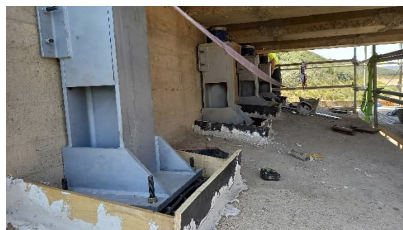
Figura 21. Pilastras sobre pilas.
