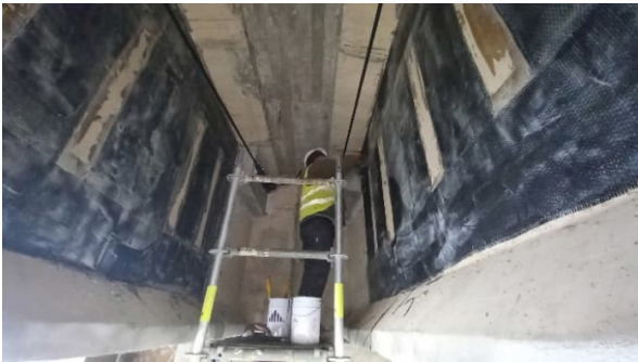
Figura 25. Colocación de TFC a cortante.
