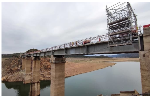
Figura 28. Andamios sobre tablero.
