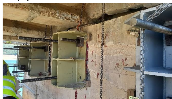
Figura 20. Ménsulas metálicas sobre estribo.
