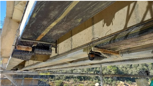
Figura 24. Colocación de TFC a flexión.
