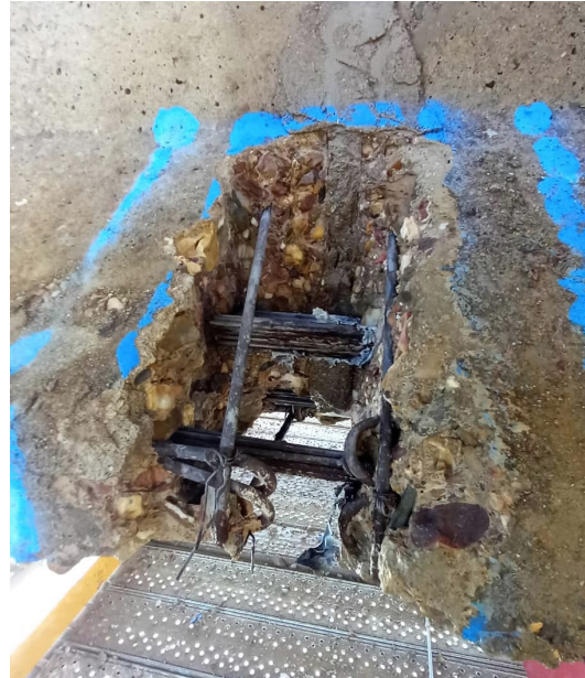
Figura 11. Catas de inspección del pretensado.
