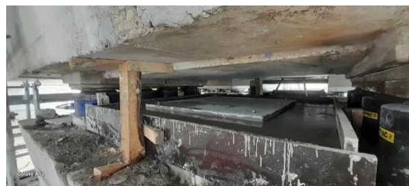
Figura 20. Ejecución de meseta inferior con masonry plate.
