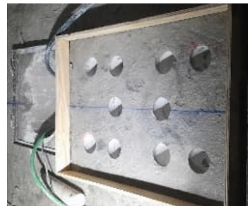
Figura 11. Taladros para instalación de shear keys.
