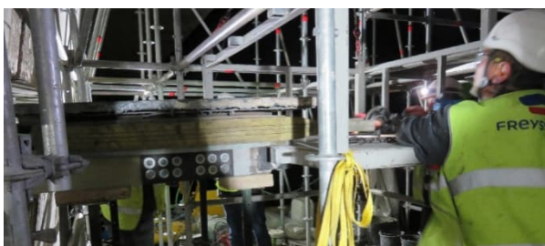
Figura 17. Extracción de apoyo
