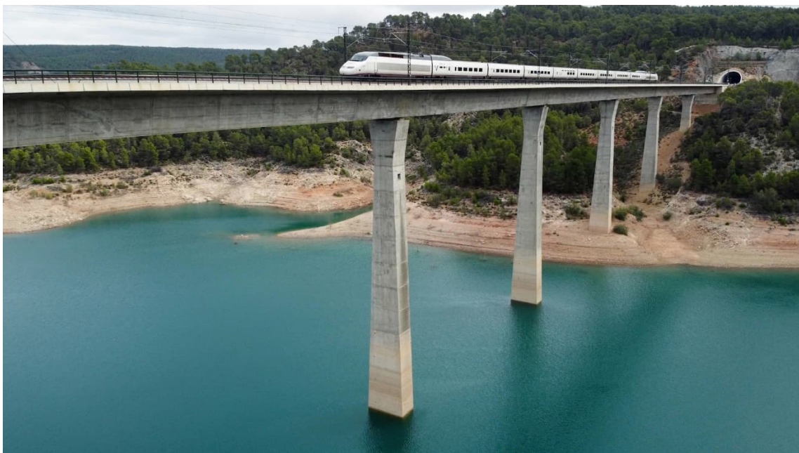
Figura 22. Vista general del puente después del cambio de apoyos o estado final
