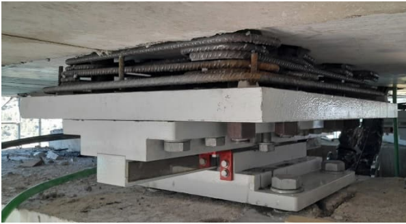
Figura 12. Llaves de cortante en instalación.
