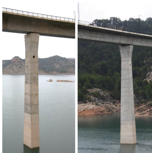
Figura 5. Imágenes de las pilas P3 (izq.) y P7.
