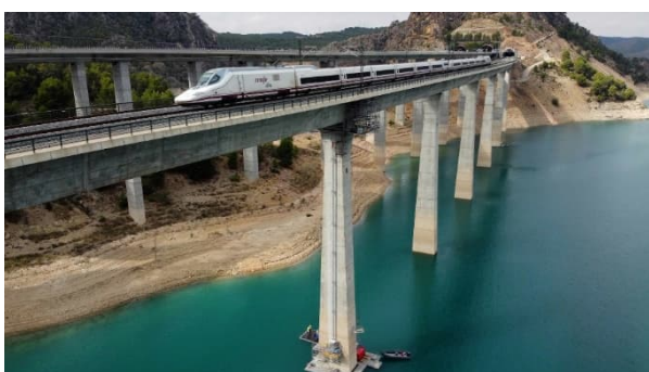
Figura 18. Tren circulando por el tablero soportado por los cilindros hidráulicos.
