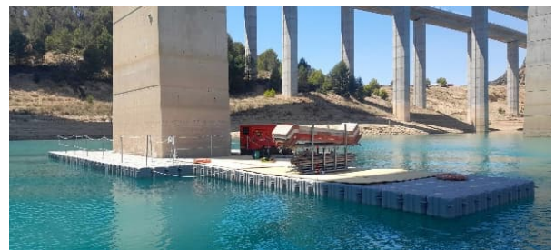
Figura 7. Plataformas de trabajo flotantes en la base de la pila.
