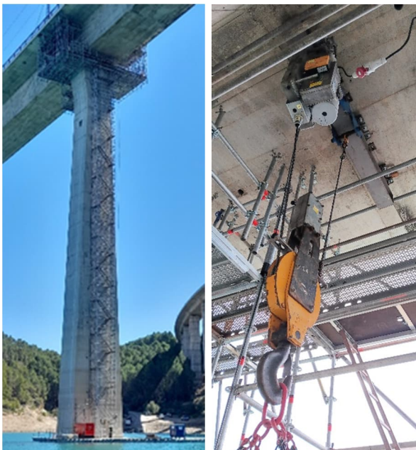
Figura 9. Vista general de la pila con andamios, accesos y plataformas (izq.) y medios de elevación.
