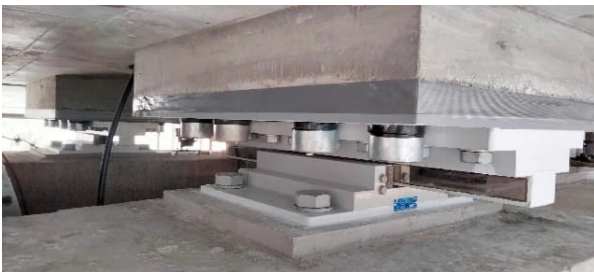
Figura 13. Llaves de cortante instaladas.
