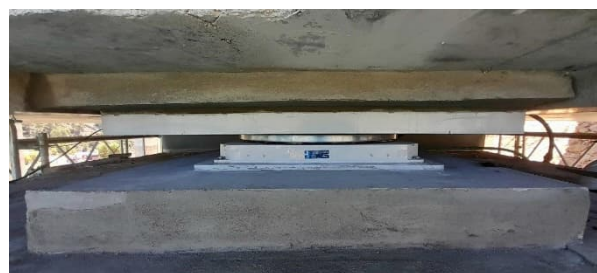
Figura 21. Apoyo nuevo instalado.
