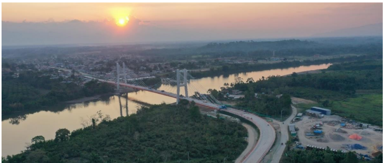
Figura 18. Vista general del Puente Huallaga.
