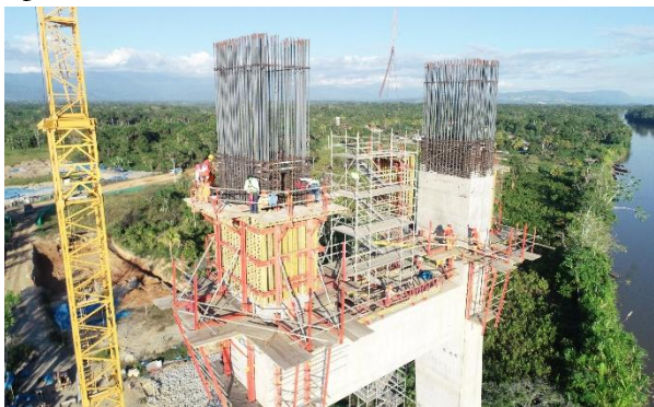
Figura 7. Detalle de ejecución de los anclajes de tirantes en torres.
