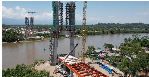
Figura 14. Montaje de losas prefabricadas del vano lateral.
