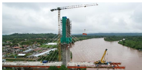
Figura 15. Izaje de viga transversal a frente de fase.
