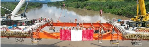
Figura 17. Colocación de vigas metálicas de la última dovela.
