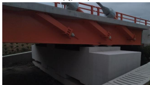
Figura 9. Vista del contrapeso ejecutado y en planos.
