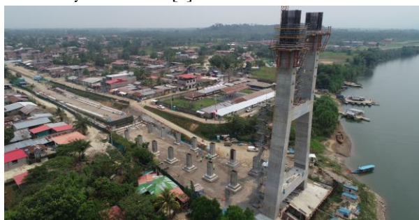
Figura 13. Detalle de los apeos provisionales dispuestos para la ejecución de los vanos laterales.
