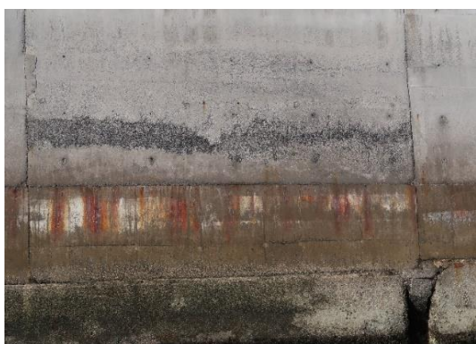
Figura 4. Tongada mal compactada
