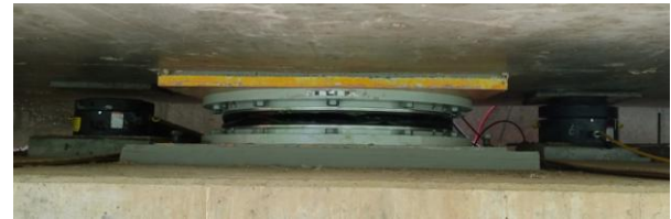
Figura 21. Vertido de resina.
