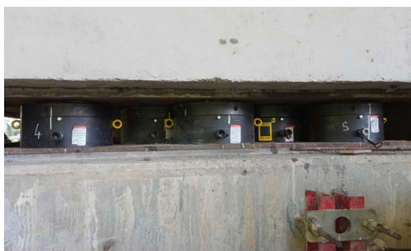
Figura 9. Disposición cilindros sobre pila
