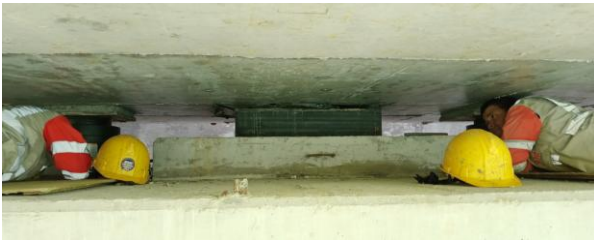
Figura 17. Retirada de apoyos elastoméricos
