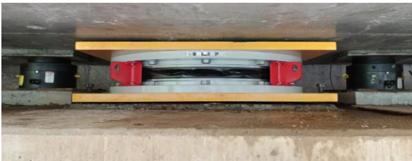
Figura 19. Colocación de apoyos.
