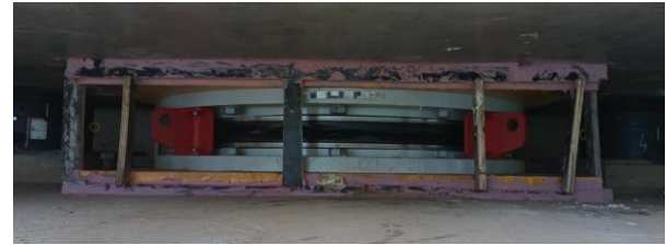
Figura 20. Vertido de resina.
