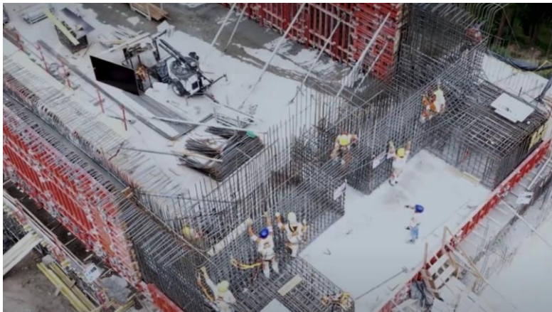
Figura 6. Estribo 5 de empotramiento con apoyo invertido
