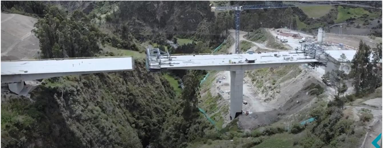
Figura 10. Vista del puente de Boquerón en construcción
