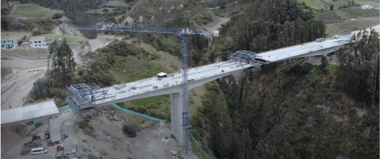
Figura 1. Vista del puente de Boquerón en construcción. Orografía
