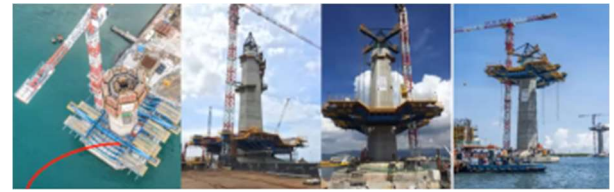
Figura 10. Montaje, izado y colocación de carros para hormigonado de dovelas de arranque en pilonos.
