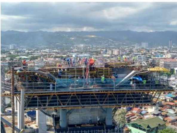
Figura 21. Construcción tablero sobre pilas S1 y S4.
