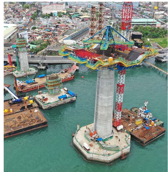
Figura 11. Carros de avance en posición final.
