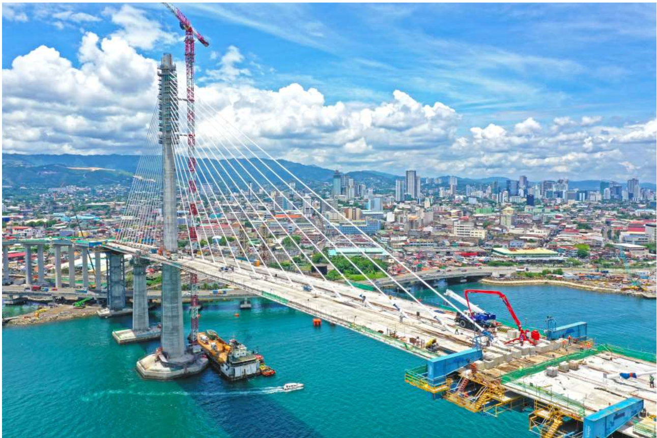
Figura 23. Cierre de vano principal. Nivelación, bloqueo, hormigonado.
