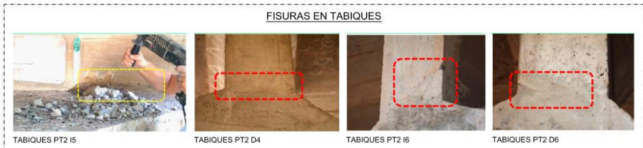
Figura 5. Estado en tabiques
