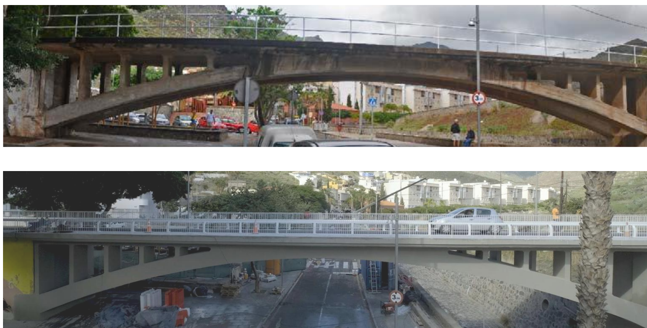
Figura 11. Estado inicial y final del puente
