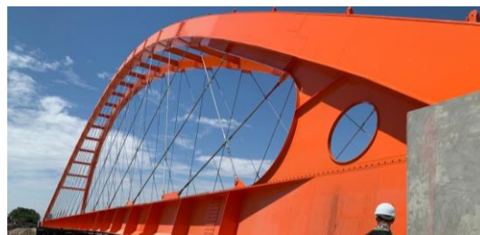
Figura 13. Detalle de la zona de unión arco-tablero.
