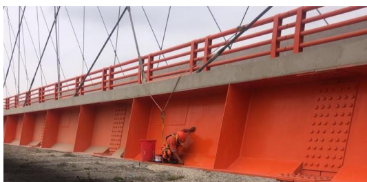
Figura 12. Vista de la unión atornillada finalizada.
