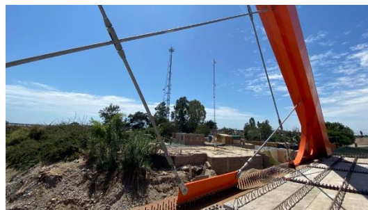
Figura 14. Detalle del cruce de péndolas.
