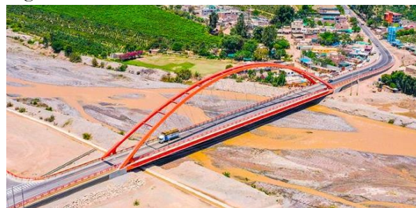
Figura 2. Puente Chamorro finalizado.
