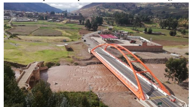
Figura 4. Vista general del Puente Combapata. (L=85.00 m)
