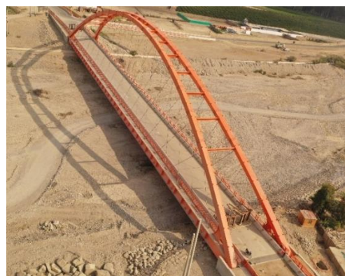
Figura 8. Detalle de la distribución de péndolas constante en tablero y en arco del Puente Chamorro.
