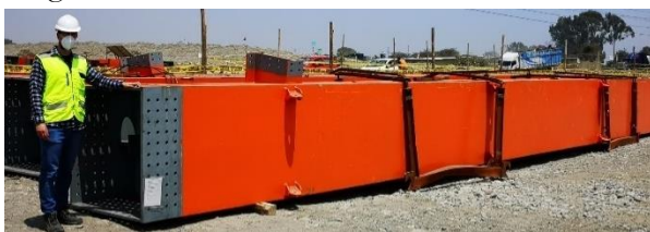
Figura 9. Detalle de los elementos del arco acopiados en obra de manera previa a su montaje.
