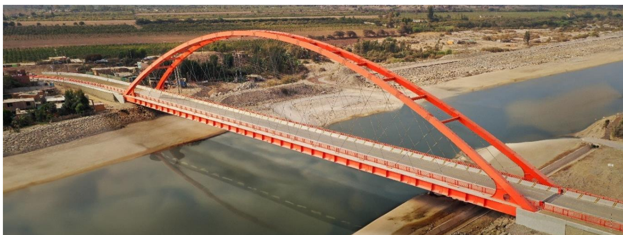
Figura 17. Vista general del nuevo Puente Chamorro.
