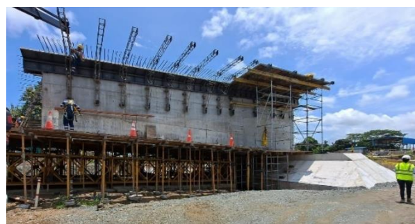
Figura 20. Construcción del tramo lateral mediante el empleo de una cimbra cuajada.
