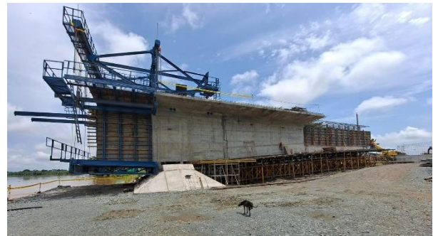
Figura 9. Detalle de la pila durante la ejecución.
