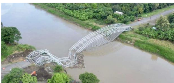
Figura 2. Vista aérea de la estructura una vez que se produjo su colapso.
