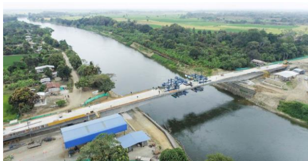
Figura 11. Empleo de carros de avance durante la construcción del vano central.
