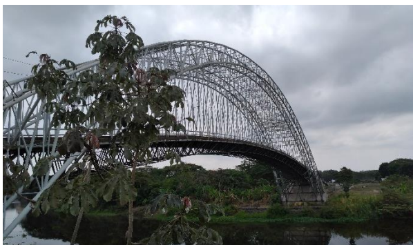
Figura 1. Elevación lateral del puente original.
