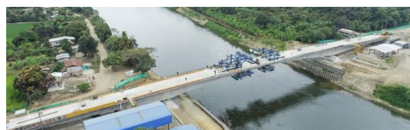
Figura 23. Vano central finalizado y posterior desmontaje de los carros de avance en voladizo.
