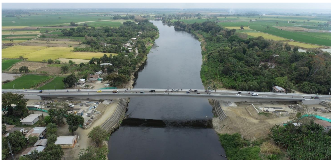
Figura 24. Vista general del Puente Colimes.
