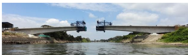
Figura 19. Construcción del tramo central por avance en voladizo con carros de avance.
