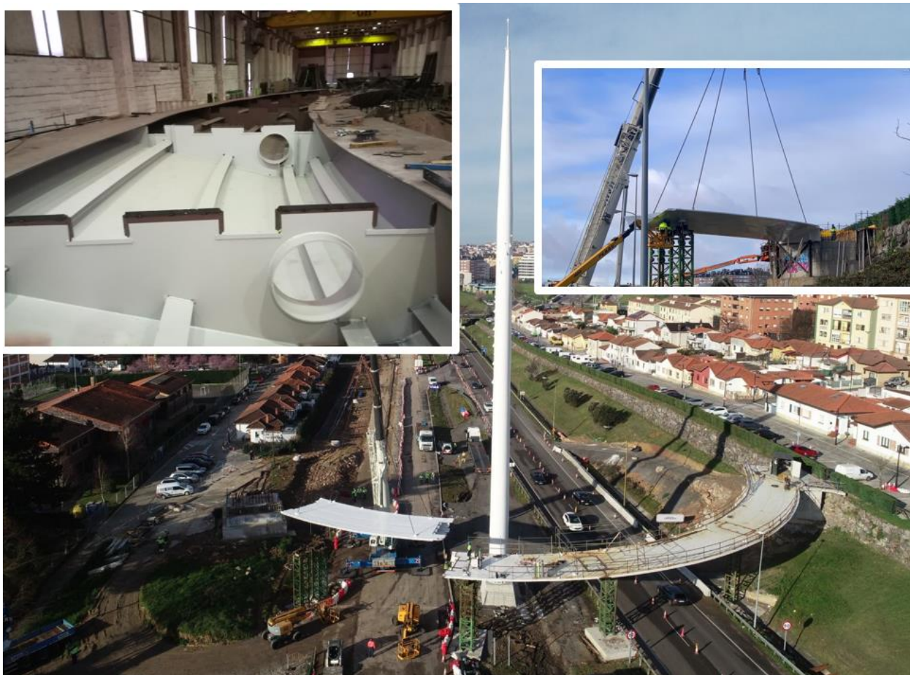
Figura 9. Diferentes etapas de fabricación y colocación del tablero.
