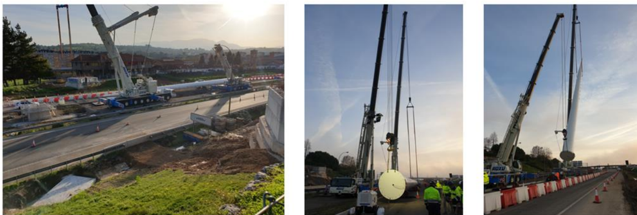
Figura 8. Diferentes etapas de izado del pilono.
