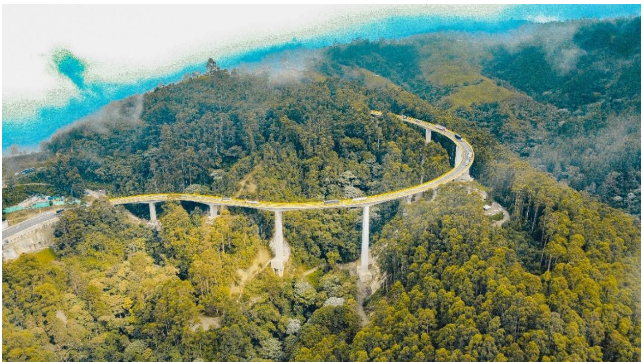
Figura 17. Vista final del viaducto de Yarumo Blanco.
