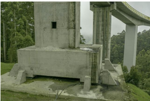
Figura 8. Bases de cimentación aisladas.
