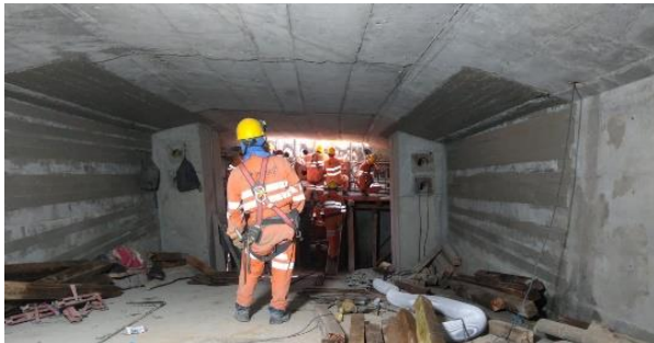
Figura 12. Anclaje de pretensado exterior y refuerzo de fibra de carbono.
