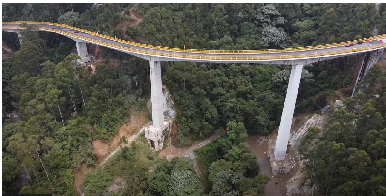
Figura 5. Aislamiento híbrido, solo en pilas cortas.
