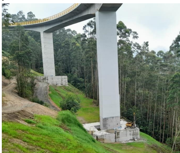
Figura 10. Pila forrada de fibra de carbono.
