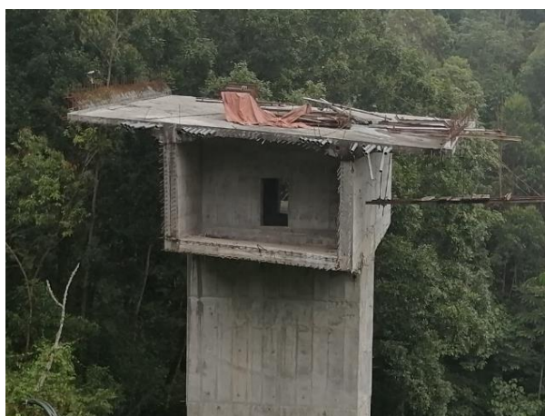
Figura 2. Sección cajón dovela 0.
