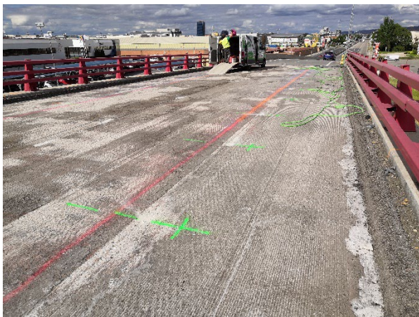
Figura 10. Plataforma fresada
