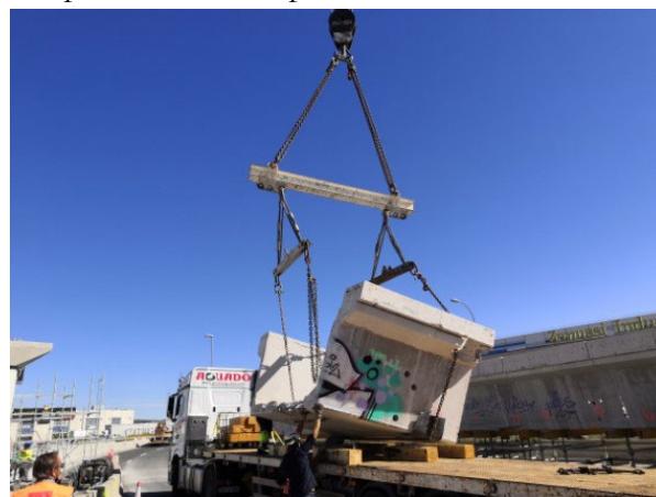
Figura 20. Izado con balancines y posicionamiento en góndolas para transporte a vertedero
