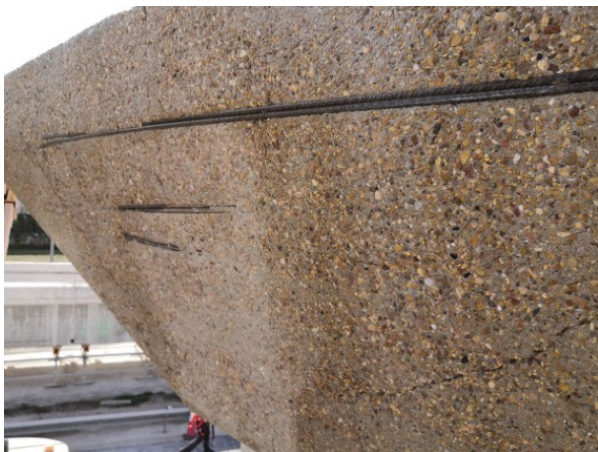
Figura 22. Rugosidad superficial en dintel de pila
