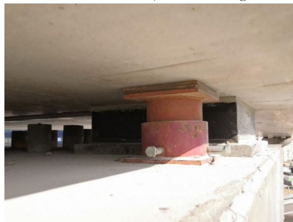
Figura 25. Caja de arena para las vigas isostáticas
