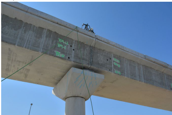
Figura 17. Corte de viga con hilo de diamante sobre pila 1
