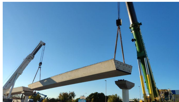
Figura 24. Montaje de las nuevas vigas artesas
