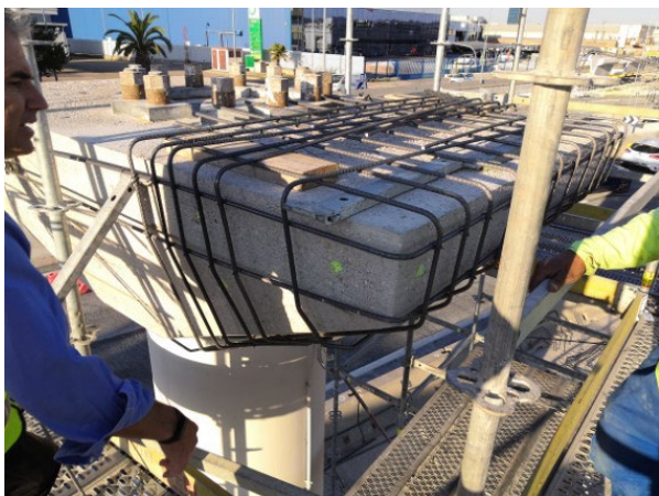
Figura 23. Ferralla del refuerzo de dintel de pila
