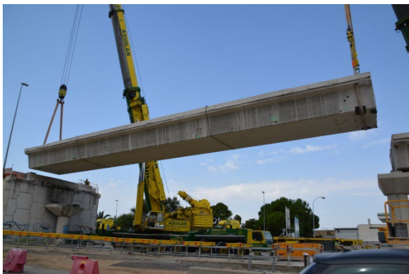
Figura 18. Izado de viga de vano 1
