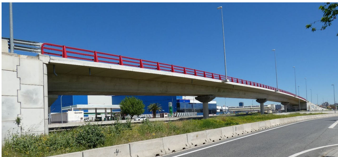
Figura 27. Aspecto del puente de la M-300, P.K. 28+900, en Alcalá de Henares tras la reconstrucción del tablero
