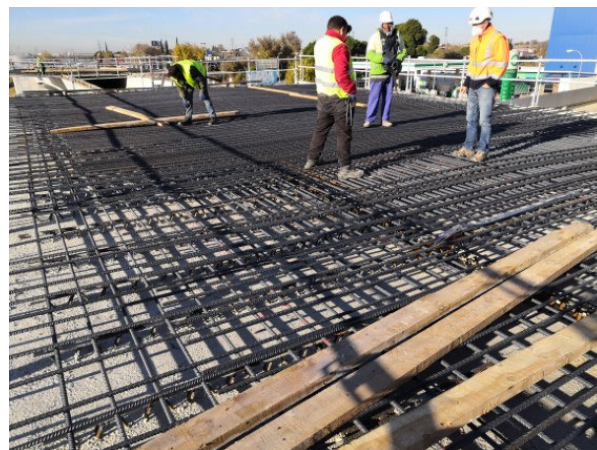
Figura 26. Ejecución de losa con prelosas en celosía
