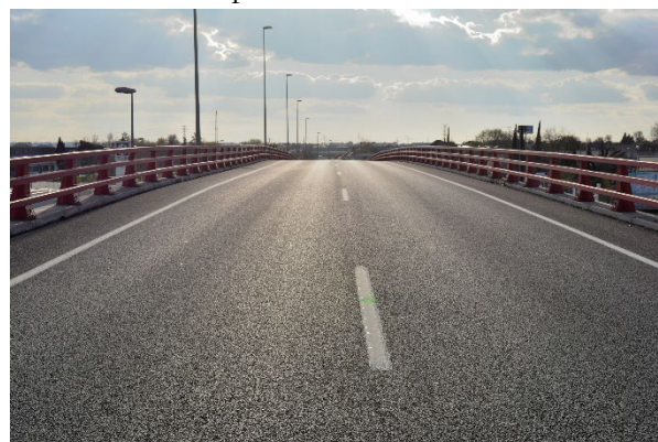
Figura 1. Vista de la plataforma superior existente
