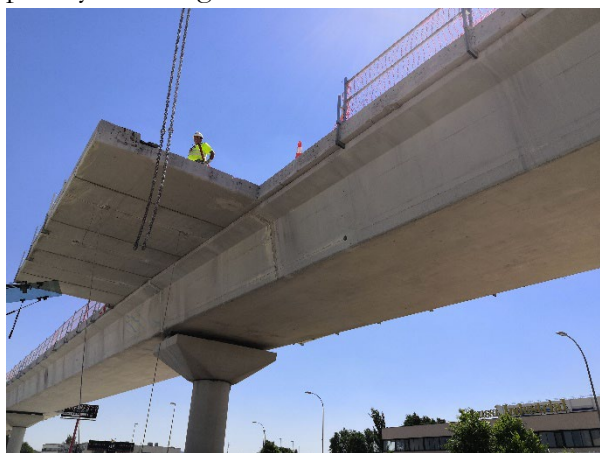
Figura 13. Desmontaje de voladizos de losa
