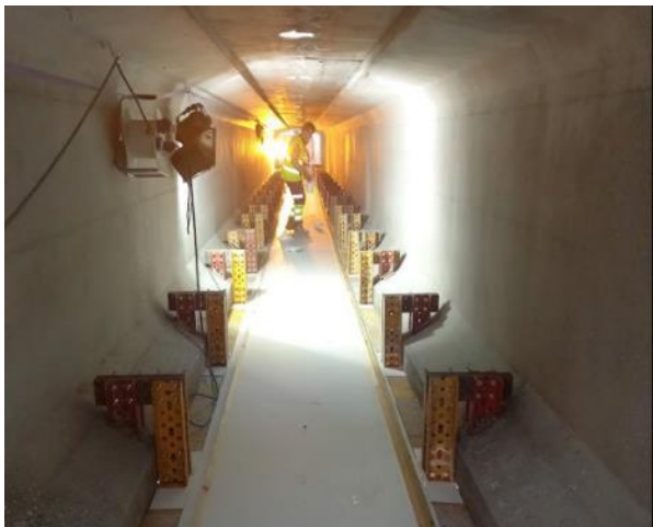
Figura 17. Vista interior de la plataforma entre las vigas de borde
