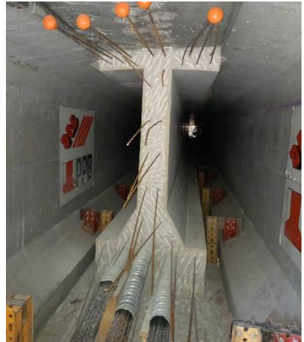
Figura 24. Fases de hormigonado de la nueva viga
