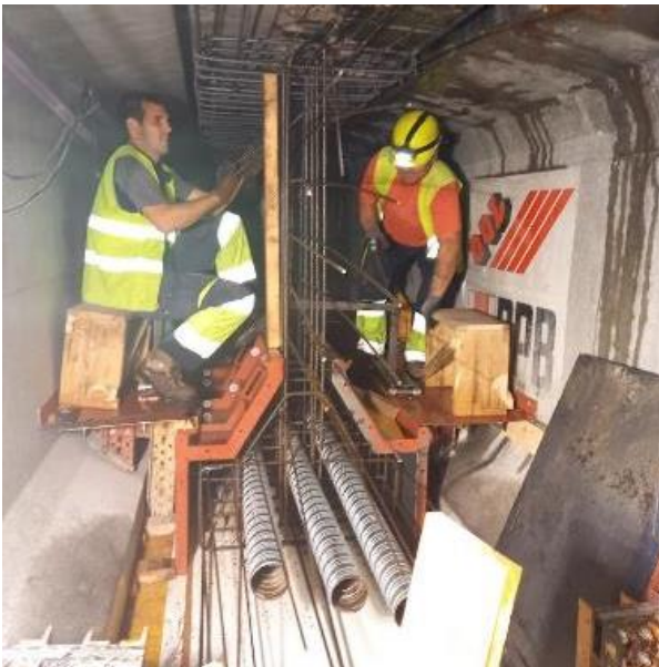
Figura 23. Trabajo de operarios en la plataforma
