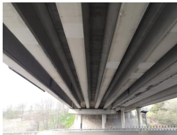
Figura 4. Vista inferior de la estructura de vigas doble T y el ensanche de artesas (derecha en la foto)
