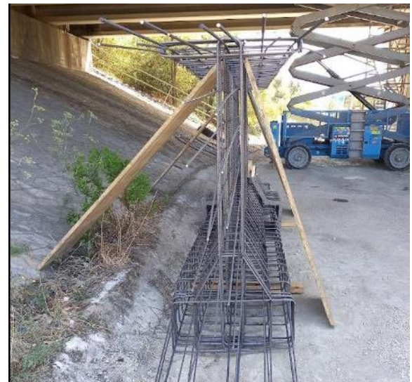
Figura 21. Módulo de armadura pasiva de la nueva viga
