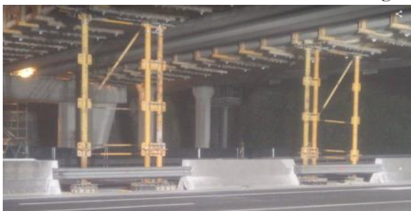
Figura 19. Puntales en centro de vano, en coincidencia con la media de la AP-15 inferior
