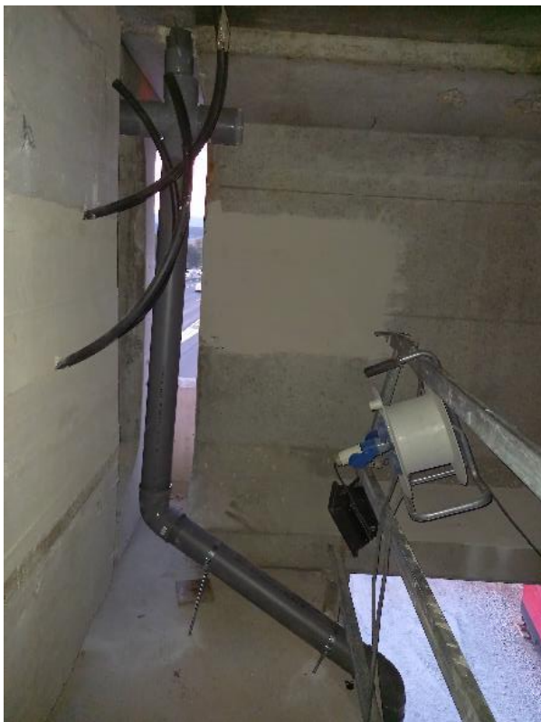
Figura 26. Nuevo sistema de drenaje
