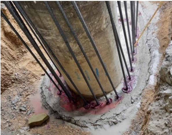
Figura 13. Barras alojadas en taladros en las zapatas de cimentación con resina epoxi
