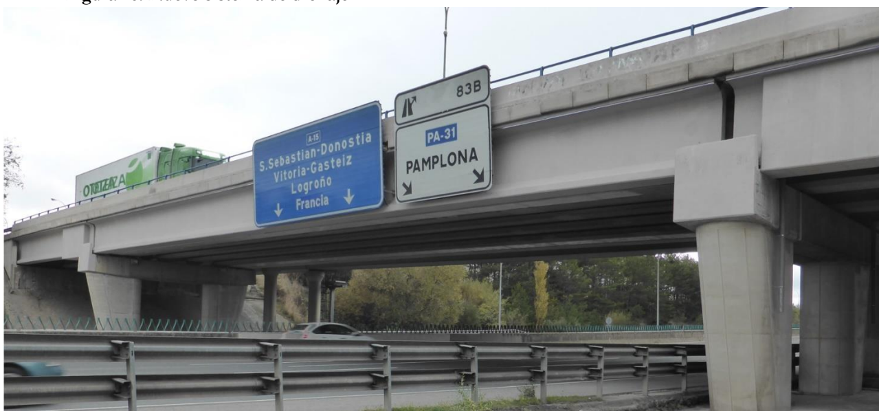
Figura 27. Aspecto del puente de la PA-30, P.K. 0+300, sobre la AP-15, en Pamplona con la reparación terminada
