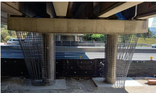
Figura 14. Parrilla de armado de cartabones de pilas
