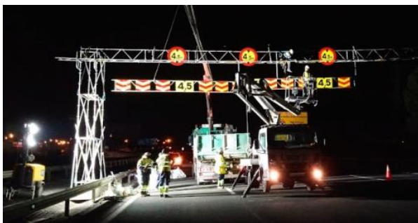
Figura 18. Pórticos pregálibo en los accesos a la estructura
