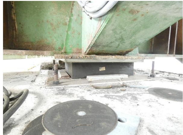
Figura 19. Nuevo apoyo de neopreno sobre pila en celosía central
