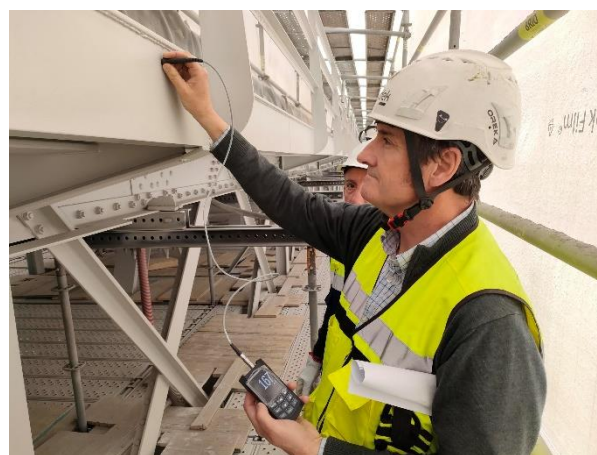
Figura 24. Comprobación del espesor de la capa de imprimación
