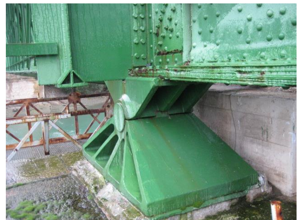
Figura 4. Apoyos fijos metálicos originales
