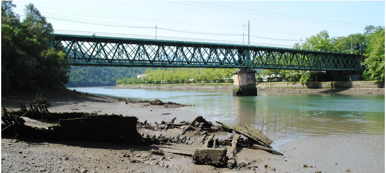
Figura 2. Alzado general izquierdo de la estructura antes de la reparación
