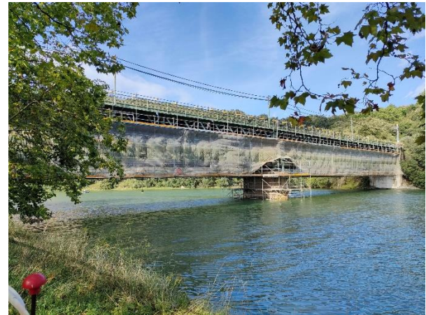
Figura 13. Andamio de tres niveles
