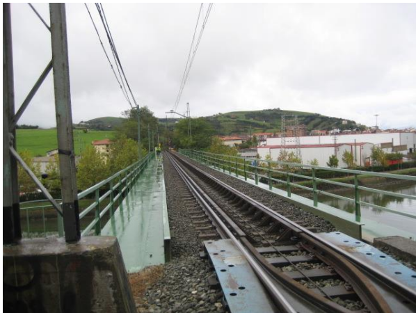
Figura 5. Plataforma previa a las obras de reparación
