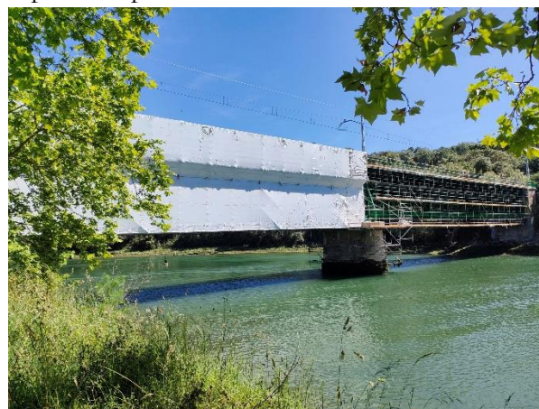
Figura 25. Encapsulado del andamio por vanos
