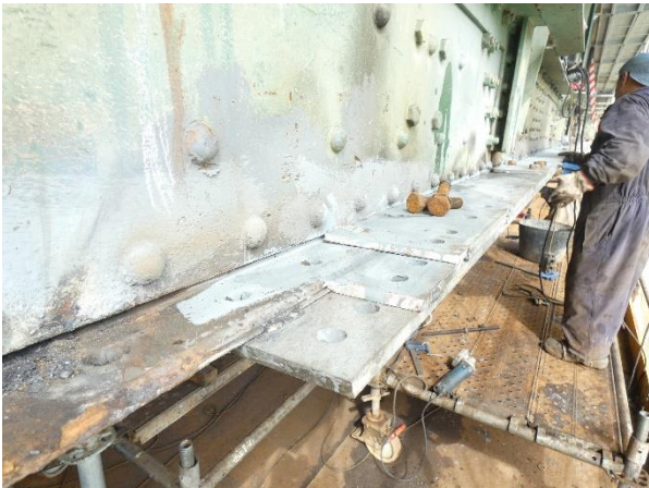
Figura 17. Decalaje longitudinal de chapas de refuerzo
