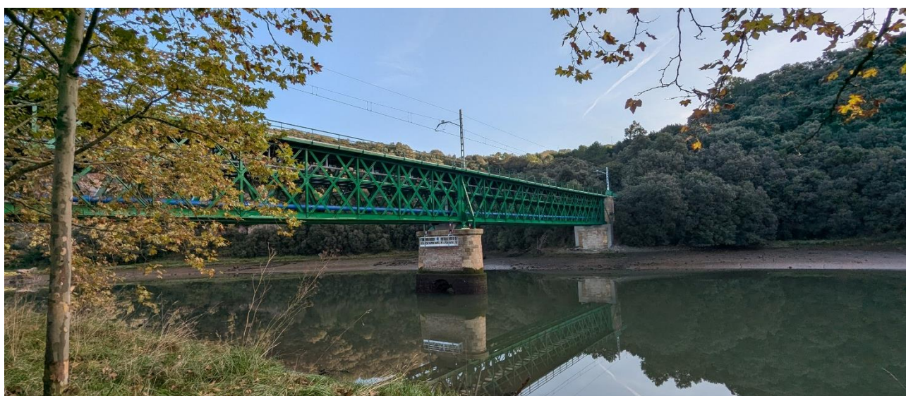
Figura 27. Aspecto del puente de ETS sobre el río Urola en Zumaia con la reparación terminada
