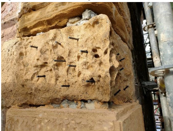
Figura 22. Barras de fibra de vidrio en fábrica
