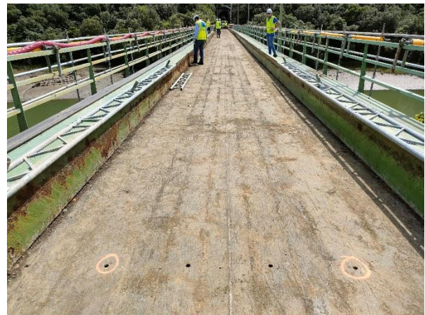
Figura 20. Plataforma ferroviaria desmontada
